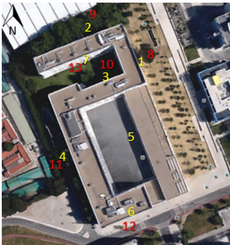
Figura 3.1: Edifício C6 da FCUL. Vãos identificados a amarelo (piso 2), a vermelho (piso 4) [28].
