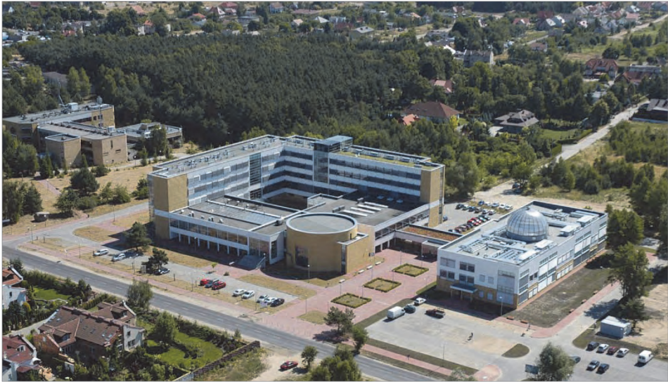
54. Gmach Collegium Geographicum im. Profesora Stanisława Pawłowskiego, w którym mieści się Wydział Nauk Geograficznych i Geologicznych UAM.
