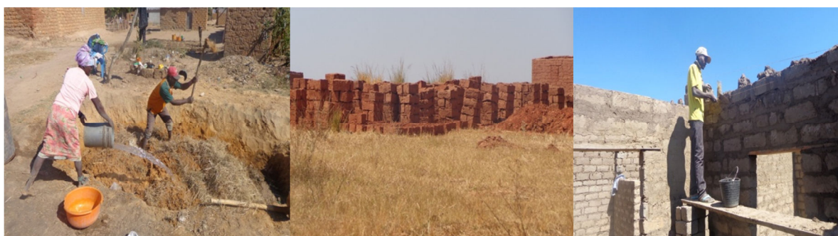
Fig. 1 - Construção em adobes na Província da Huíla: (A) Mistura do solo com água e capim; (B) Secagem ao ar livre dos blocos de adobes; (C) Edificação das paredes com adobes e argamassa de terra crua.
