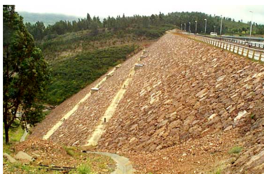
Figura 38. Barragem de enrocamento com cortina de betão a montante da Apartadura (CNPGB).
