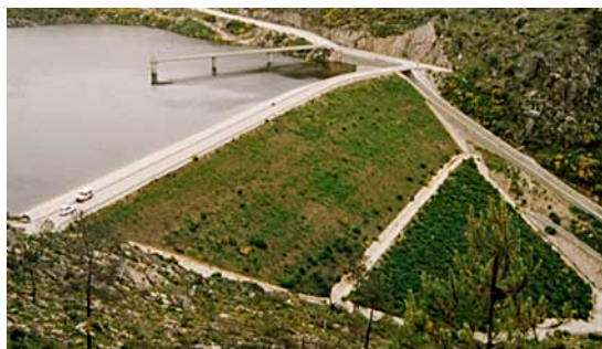
Figura 32. Barragem de terra zonada com tapete drenante e dreno chaminé inclinado do Alijó (CNPGB).
