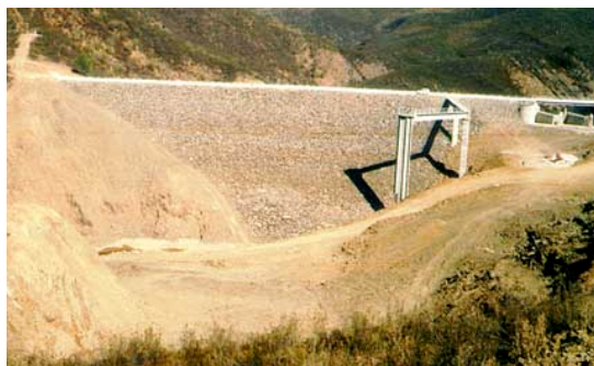
Figura 34. Barragem de terra e enrocamento com núcleo central de Alcoutim (CNPGB).
