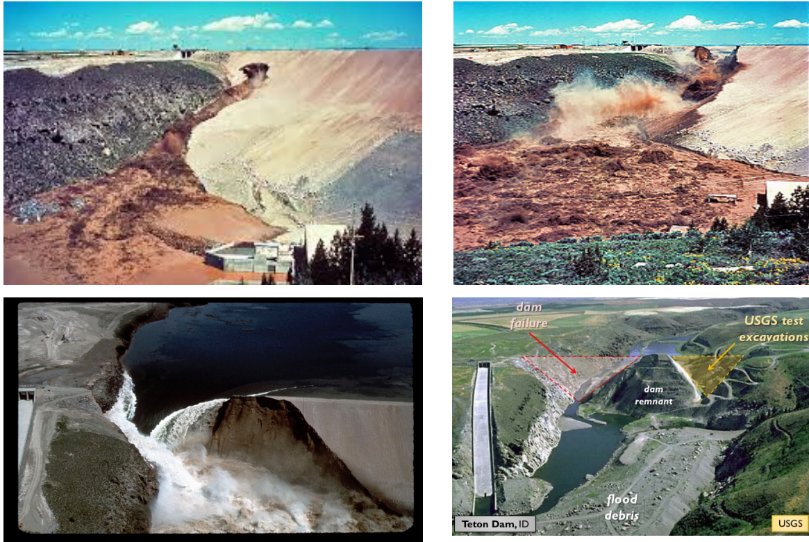
Figura 20. Rotura da barragem de Teton (USA) devido a erosão interna( http://www.geol.ucsb.edu/faculty/sylvester/Teton_Dam/narrative.html ).
