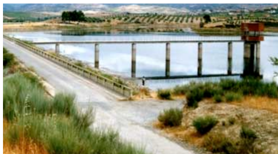
Figura 26. Barragem de terra homogénea com dreno de pé de jusante do Salgueiro (CNPGB).
