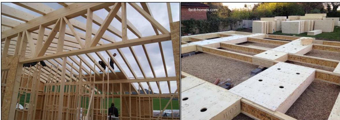
Imagen 3. 10 Construcciones de madera con elementos prefabricados
