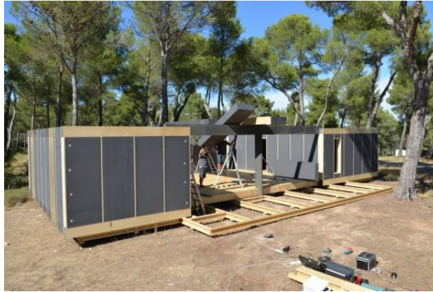
Imagen 2. 28 Construcción de vivienda a base de paneles
