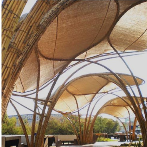
Imagen 3. 14 Techumbres orgánicas con soportes de caña
