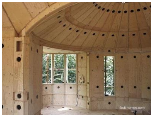
Imagen 2. 26 Construcción con sistema D-process
