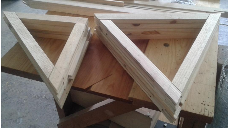
Imagen 4. 7 Fabricación de bastidores para módulos constructivos Fuente: Foto propia.
