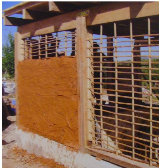
Imagen 3. 12 Construcción de muro con técnica bajarque
