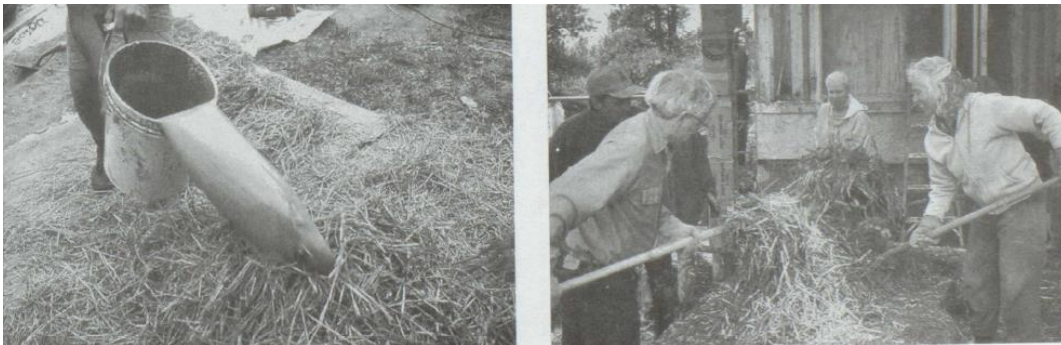
Imagen 3. 13 Construcción con técnica arcilla aligerado
