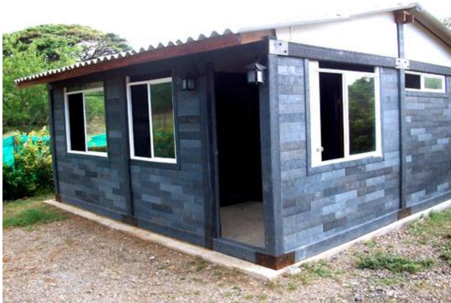
Imagen 2. 24 Vivienda construida con sistema constructivo Brickarp
