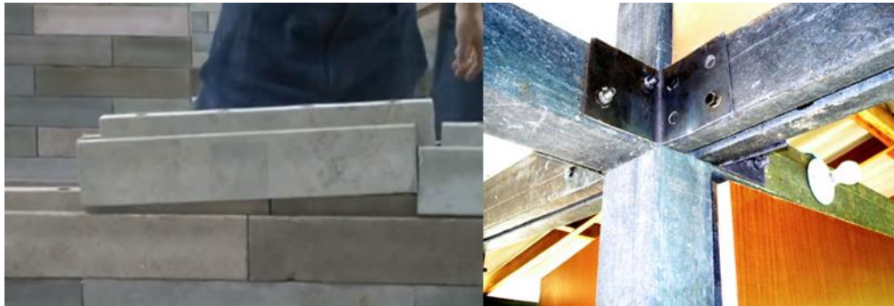
Imagen 3. 6 sistema constructivo Brickarp compuesto de bloques de plástico Fuente: http://www.ficidet.com/brickarp/inicio.htm
