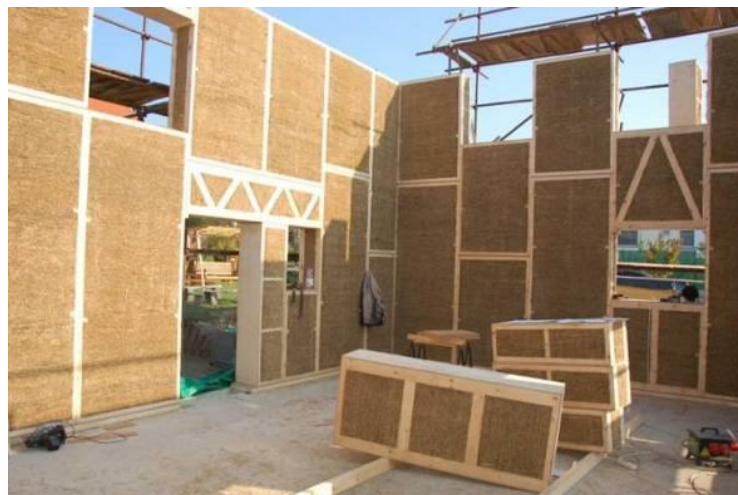
Imagen 2. 30 paneles en la construcción
