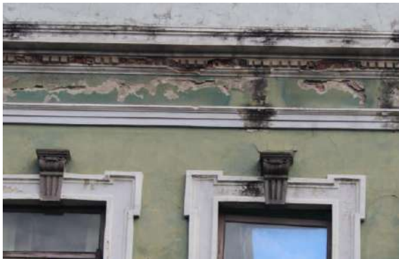
Figura 95. Fotografía de detalle Fachada Sur
