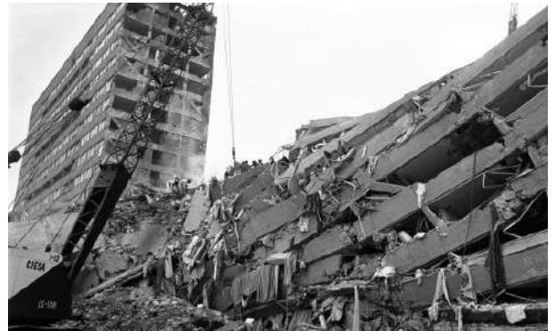
Figura 8. Uno de los edificios derrumbados tras el terremoto de 1985. Fuente: elpais.com . 22 de Marzo del 2012.
