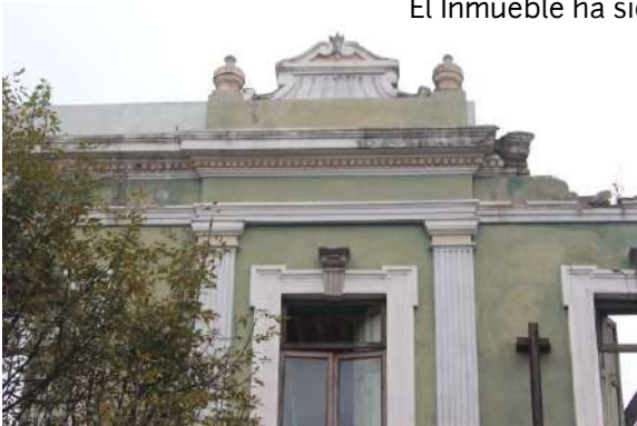
Figura 93. Fotografía de detalle Fachada Sur
