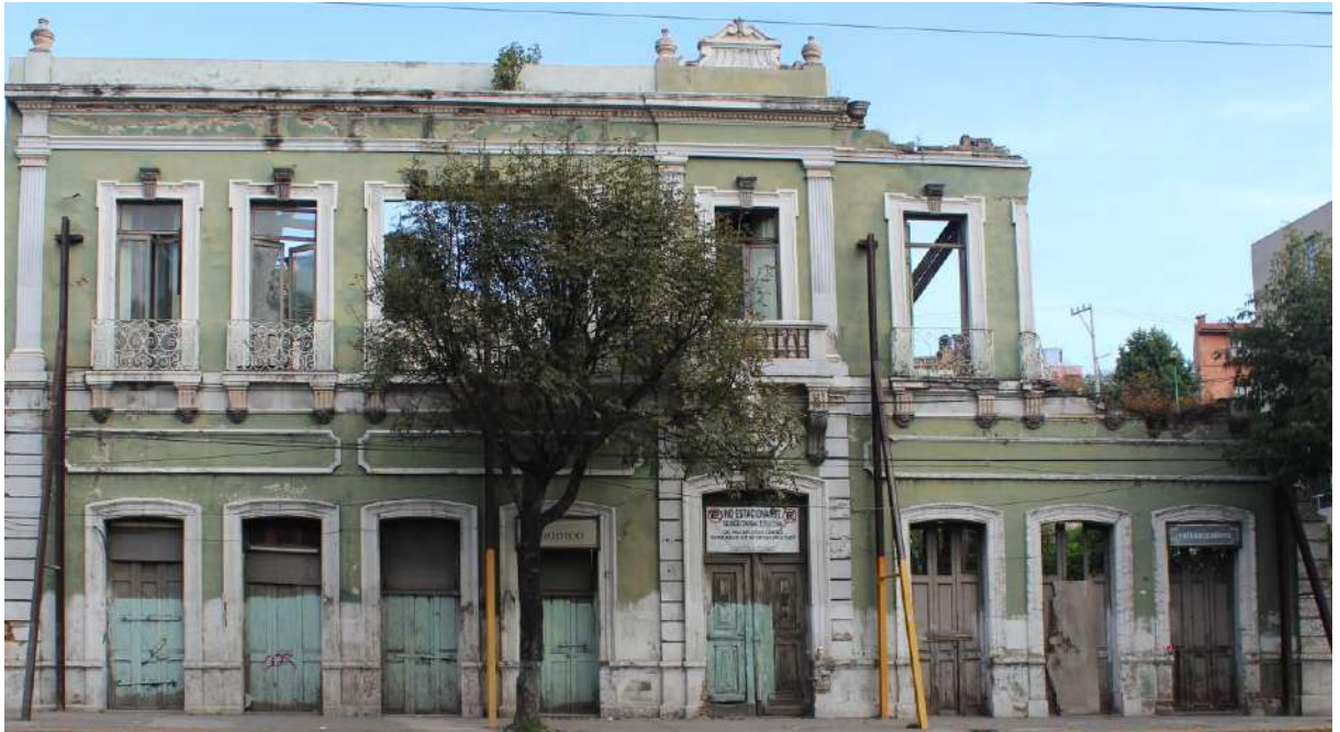
Figura 92. Fotografía Fachada Sur El inmueble ha sido demolido en gran parte.
