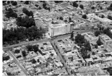
Figura 13. Edificio Ermita de J. Segura. Fuente: Pinterest/ Jorge Bravo, Marzo 2017
