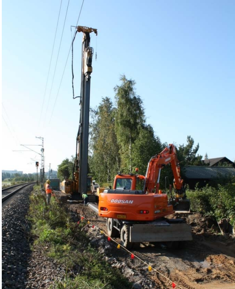
Kuva 6.2. Ponttiseinän asennusta sekä työmaatien tekoa.
