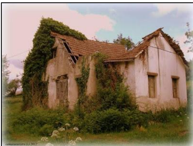
Figura 15: Exterior dunha casa abandonada na que se realizou urbex
