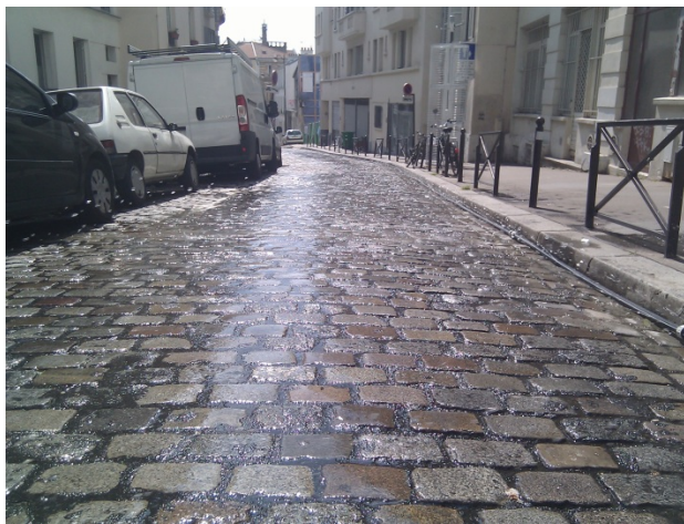
Figure 3 : Arrosage par tuyau percé de la rue Lesage
