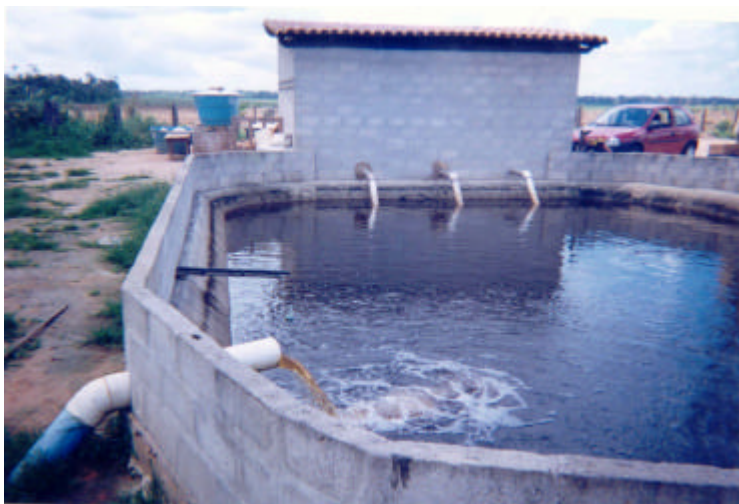
Fig. 3. Detalhe do tanque de recalque antes da pré-filtração da água contendo ferro precipitado. Calliman Agrícola – Linhares - ES. Foto: Sílvio Tavares.
