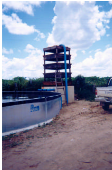
Fig. 2. Torre de aeração para água contendo ferro precipitado, a ser utilizado em sistema de irrigação localizado. Calliman Agrícola – Linhares - ES.
