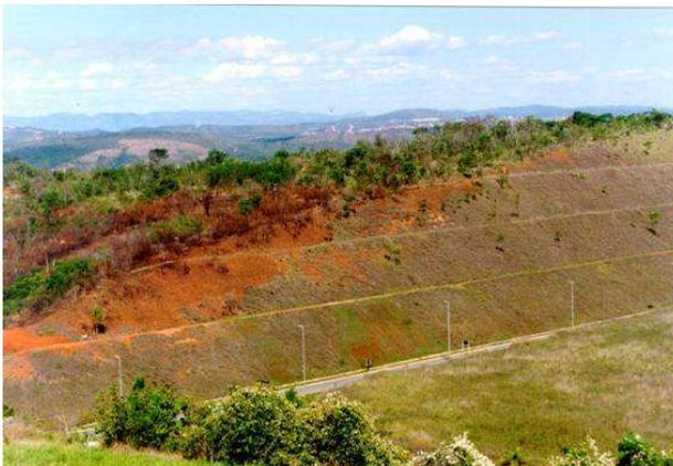
Figura 3. Problemas de erosão em taludes de corte do Aeroporto Internacional de Confins MG.
