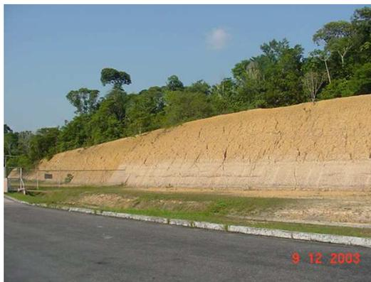
**Figura 4.** Talude de corte desprovido de vegetação apresentando erosão em sulcos e ravinas em talude do Aeroporto de Manaus.
