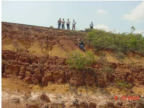
**Figura 5.** Taludes de corte próximo à pista de taxiamento do aeroporto de Manaus, apresentando forte processo de erosão laminar, em sulcos e ravinamentos.
