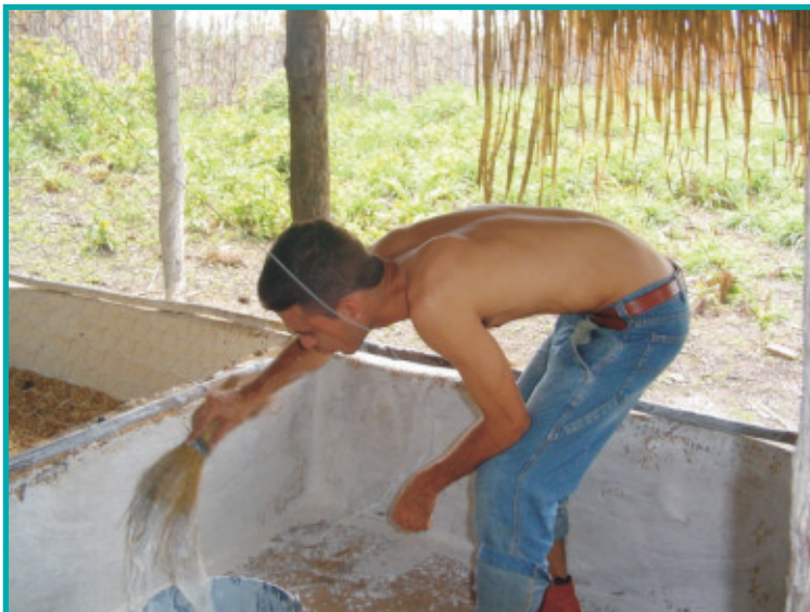
Fig. 46. Higienização das instalações por meio de caiação.
