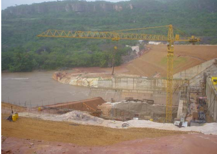
Barragem sendo construída em dezembro de 2007, no rio São Lourenço (MT). Foto: Marlene Mármora
