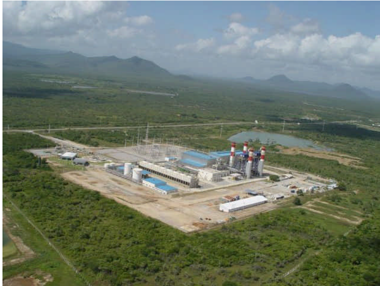
Fig. 2. Visão geral da “Central Termelétrica Endesa de Fortaleza” que ocupa uma área de 70.000m 2 no município de Caucaia, CE.
