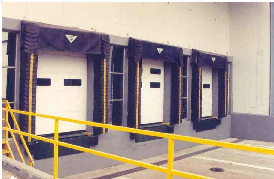
**Figura 21.** Instalação externa de rampa de embarque/desembarque preparada de acordo com a altura da caçamba do veículo transportador, com borracha de vedação.
