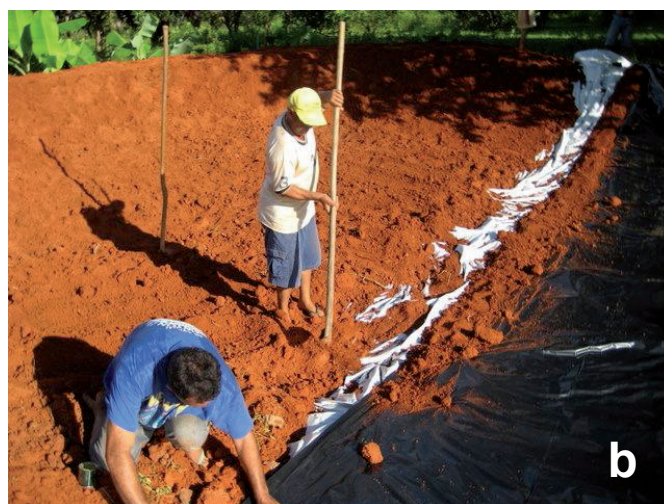
Figura 2. Escavação para construção do lago de múltiplo uso (a) e colagem da lona e cobertura com terra (b).
