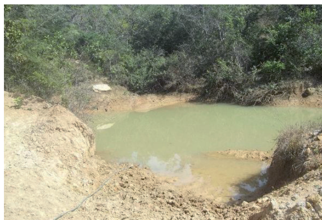
Figura 10. Barraginha construída na parte inferior da propriedade , sustentada pela umidade subterrânea das barraginhas dos pontos médio e superior.
