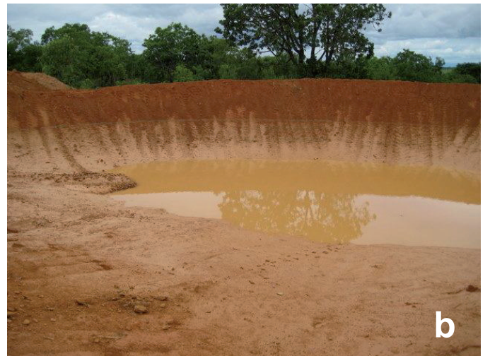
Figura 4. Barragem com água da chuva colhida (a) e após infiltração parcial no solo (b).
