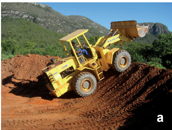
Figura 1. Barraginha em construção utilizando pá-carregadeira (a) ou retroescavadeira(b)
