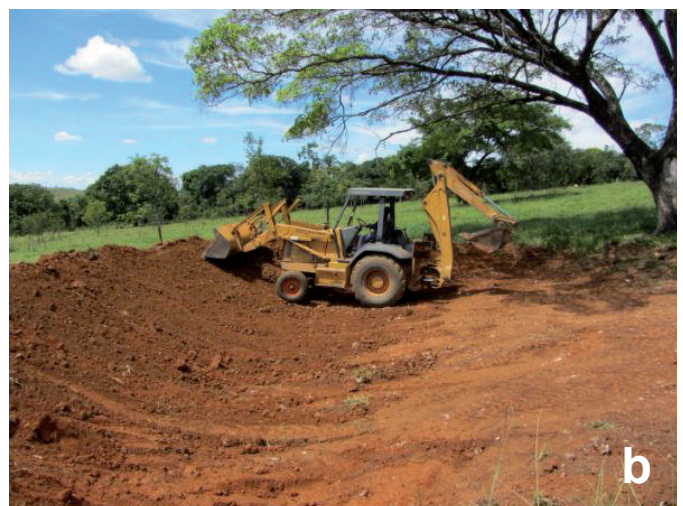
Figura 1. Barraginha em construção utilizando pá-carregadeira (a) ou retroescavadeira(b)
