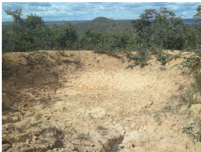
Figura 8. Barraginha construída em ponto mais elevado da propriedade , já descarregada.
