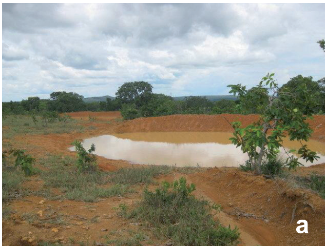
Figura 4. Barragem com água da chuva colhida (a) e após infiltração parcial no solo (b).
