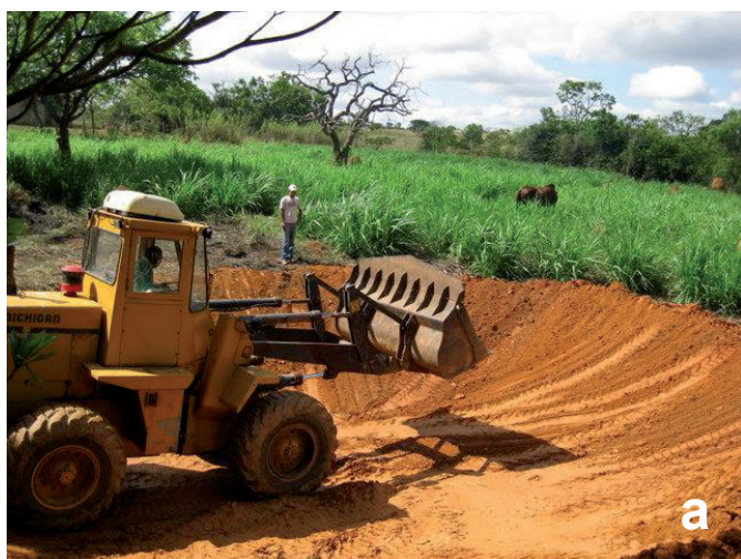
Figura 2. Escavação para construção do lago de múltiplo uso (a) e colagem da lona e cobertura com terra (b).
