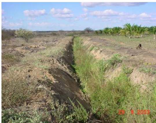
Fig. 3. Dreno coletor secundário, lote 406.
