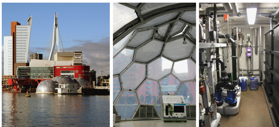
Ryc. 4. Pływający pawilon; widok z zewnątrz (A), wewnątrz (B) oraz wnętrze platformy, na której się znajduje (C) z instalacjami zapewniającymi samowystarczalność budynku Fot. A. Bilska.
