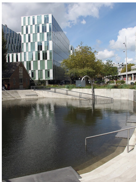
Ryc. 3. Jeden ze zbiorników retencyjnych na skwerze wodnym Bethemplein; zazwyczaj funkcjonuje jako boisko (A), w czasie zwiększonych opadów gromadzi wodę (B) Fot. A. Biliska.
