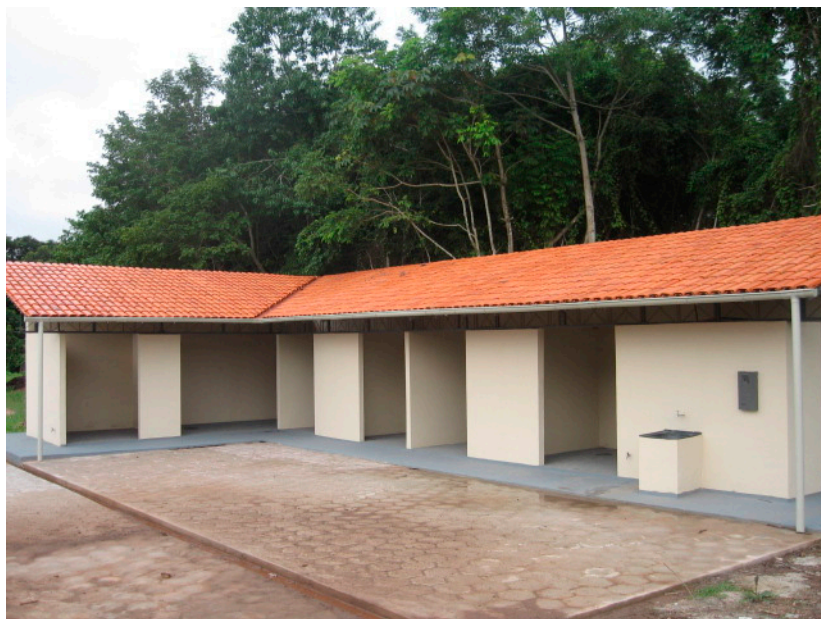
Figura 3. Unidade de destinação temporária de resíduos (UDTR), construída na Embrapa Amapá.
