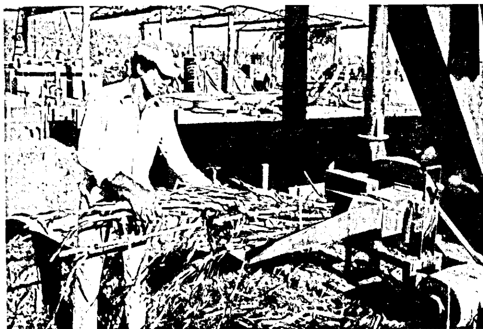
FIG. 4 – Desintegração dos colmos de sorgo sacarino
