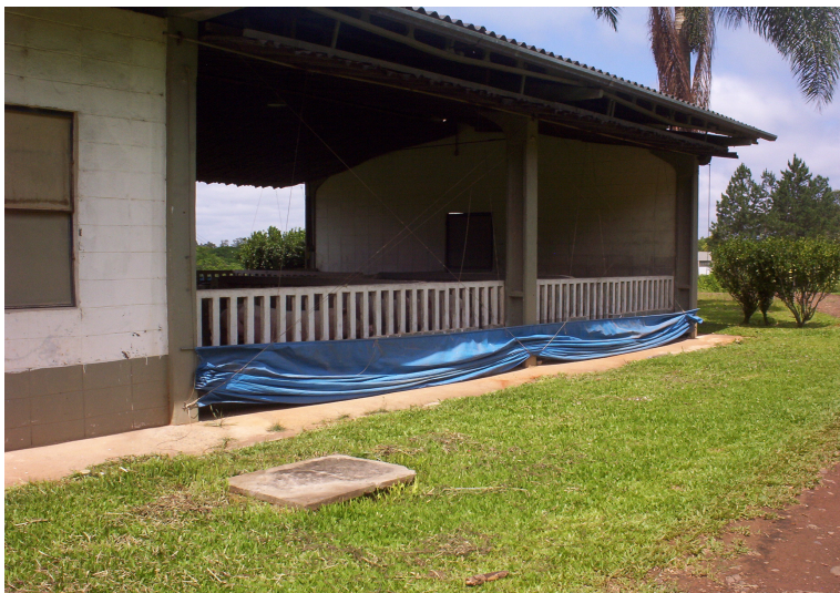
Fig. 2 - Exemplo de edificação para a produção de suínos em estrutura de concreto pré-fabricada, detalhe das paredes laterais e de canal para manejo dos dejetos coberto.
