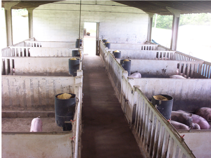
Fig. 3 - Divisórias de concreto pré-fabricadas, facilitando a ventilação natural.
