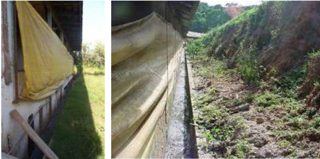
Fig. 6 - Erros freqüentes de construção dos canais externos, contribuindo para introdução e mistura da água da chuva com os dejetos.
