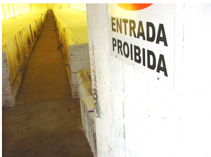
Foto1 - Instalação de placa de advertência.
