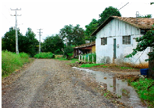
Foto 4 - Instalação construída em local inadequado (próximo à estrada).
