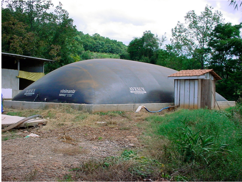
Biodigestor com o gasômetro cheio de biogás.
