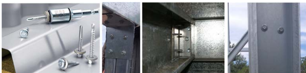
Figura 1 – Utilização de parafusos autoperfurantes nos perfis enformados a frio.
