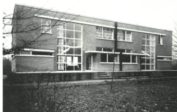
Achtergevel van De Zilverbron , Brasschaat (A.M.V.C.)
