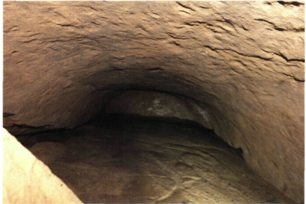
Een deels dichtgeslibde maar goed bewaarde aacht in Riemst was toegankelijk vanuit een kleine bakstenen kelder (foto's P. Van den Hove)
