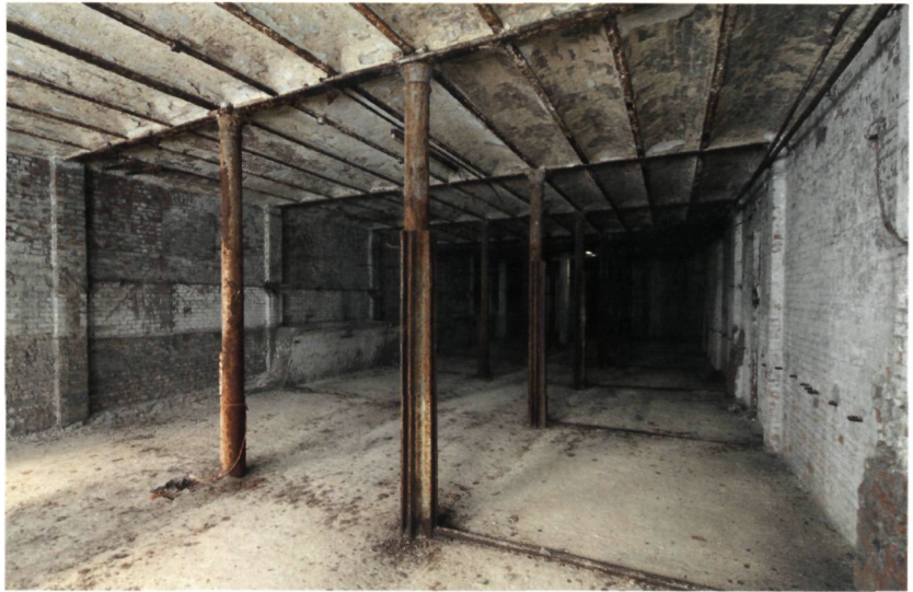
De opbouw van de stallen is industrieel met gietijzeren kolommen en bepleisterde troggewelven (foto O. Pauwels)
