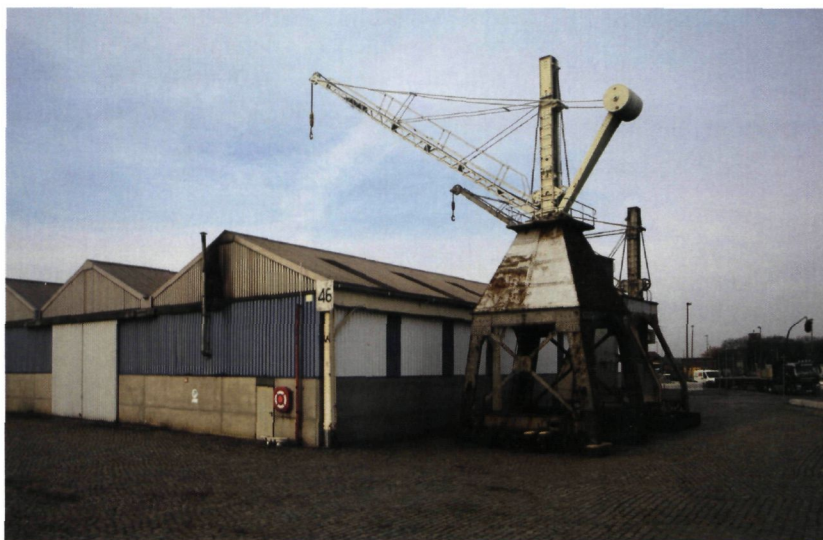
De hydraulische portaalkraan 97 gebouwd door de Union Métallurgique uit Luik, toestand in 2013 (foto K. Vandevorst)
