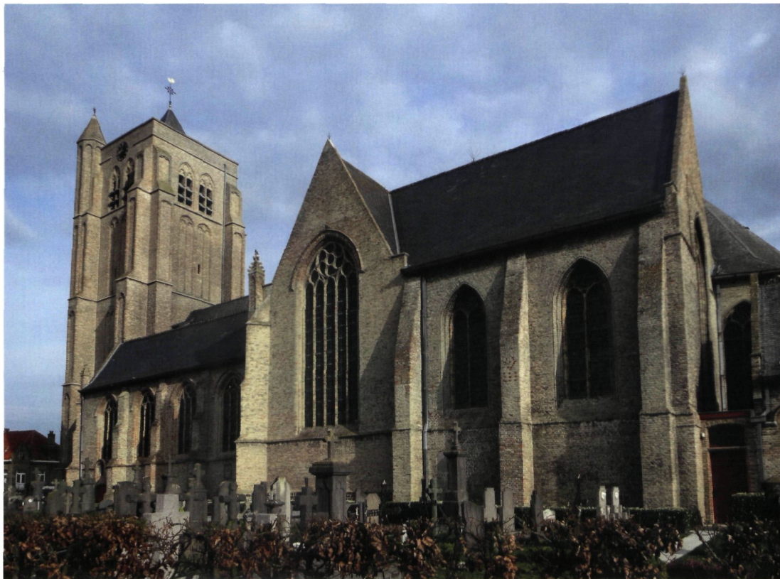
De imposante Sint-Pieterskerk in Esen werd door architect Thierry Nolf gereconstrueerd naar vooroorlogs model, met imposante westtoren en het volumespel tussen het driebeukige schip en het bredere transept en hallenkeor (foto K. Himpe)
