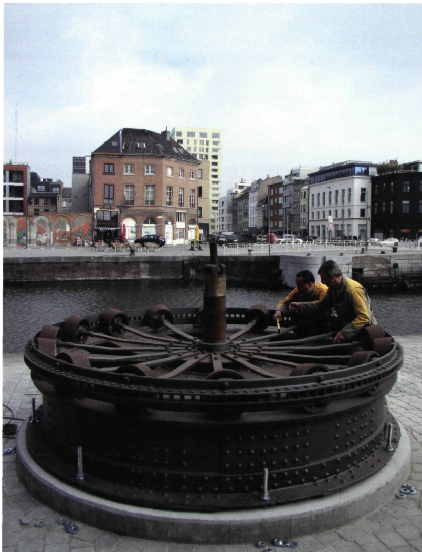
De montage van de sokkel voor de Stuckenholzkraan bij het MAS begin april 2011 (foto J. Vrelust)
