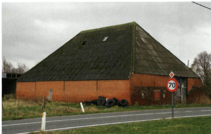
Oud Arenberg 75. In 1927 worden een gedeeltelijke afbraak en vergroting kadastraal geregistreerd. Hierbij wordt het volume van de schuur blijkbaar licht afwijkend en ruimer (verbreding met stal?) ingetekend. Aan de gebruikte baksteen is tevens te zien dat de wanden van de schuur toen werden verhoogd, na een eerste versterking rond 1900 (foto E. Wauters)
