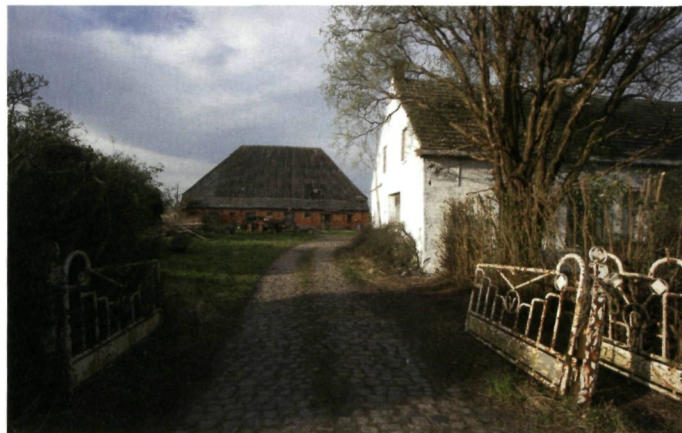
Het woonhuis dateert waarschijnlijk uit het begin van de 19de eeuw. Door het toenemend belang van de veeteelt aan het einde van de 19de eeuw is er nood aan bijkomende stallen, waarvoor schuren worden uitgebreid aan de kant van de woning, met deuren die rechtstreeks uitgeven op het binnenerf (foto O. Pauwels)
