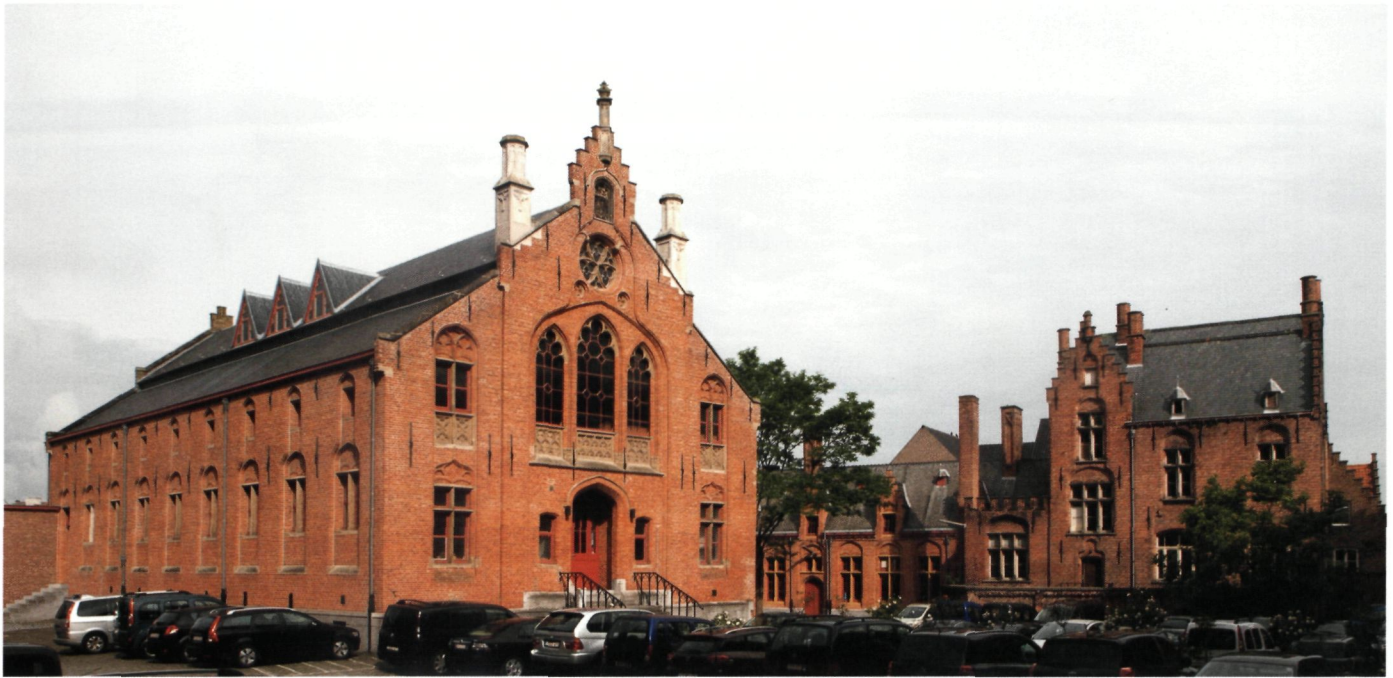
Vrijstaande gymzaal in het midden van de tweede binnenkoer (foto O. Pauwels)
