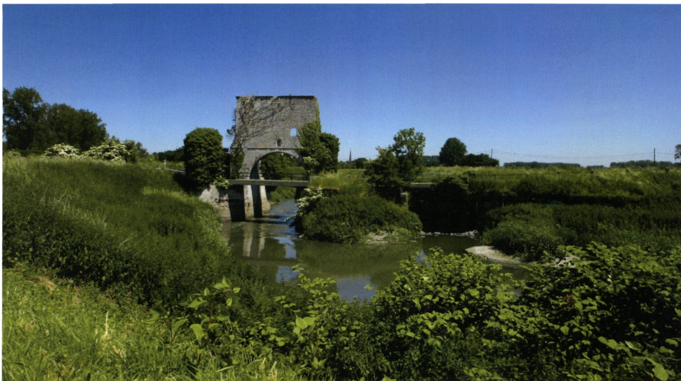
Huidig uitzicht van de restanten van de sluis (foto K. Vandevorst)
