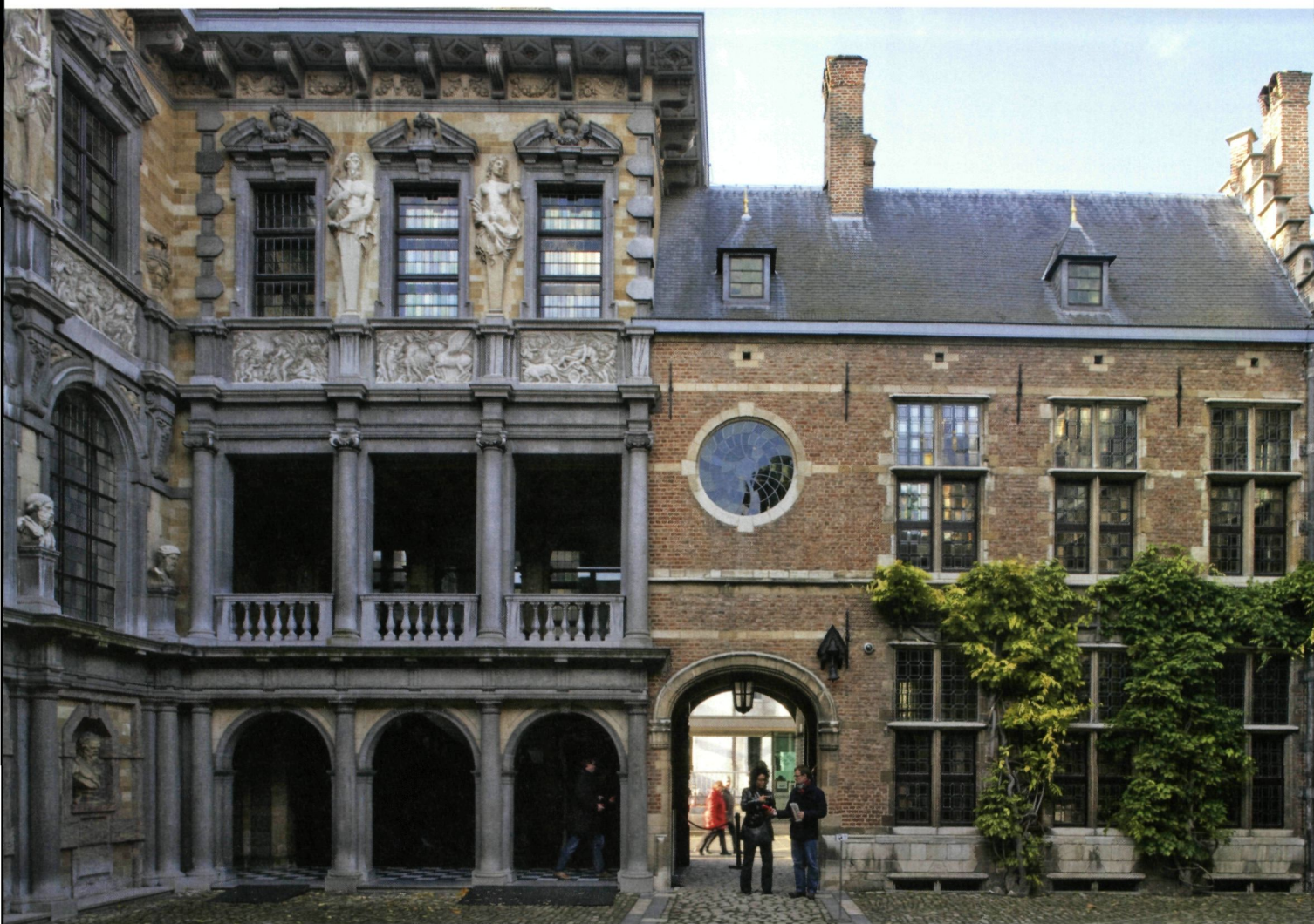
Blik vanaf de binnenplaats op de hoofdingang met aan de linkerzijde het schilderhuys en aan de rechterzijde het woonhuis (foto O. Pauwels)
