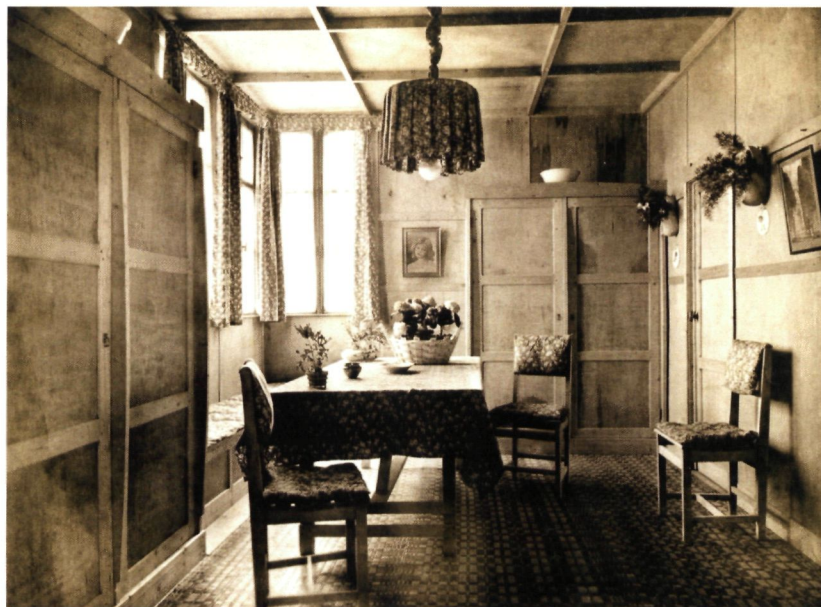
Interieur van een houten noodwoning vervaardigd in Den Haag (© Archives d'Architecture Moderne, Brussel)
