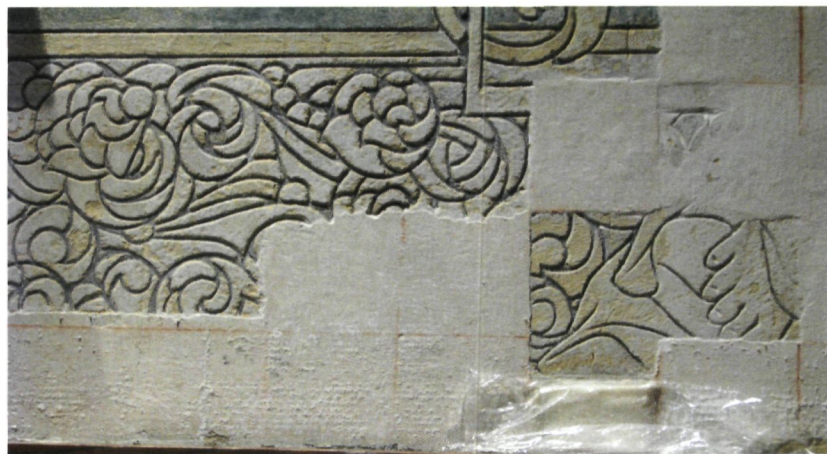
Detail tijdens het blootleggen na het verwijderen van het glasvezelbehang (foto E. De Boer)
