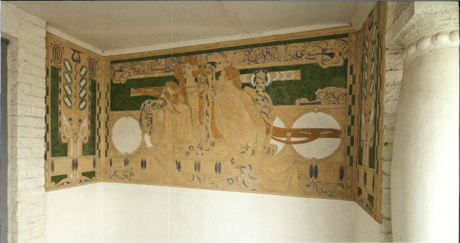
Sgraffiti van het terras na restauratie (foto O. Pauwels)
