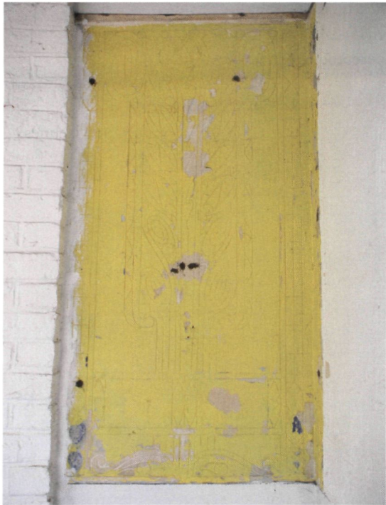
Een paneel van het terras was overschilderd in een gele kleur (foto M.-H. Ghisdal)
