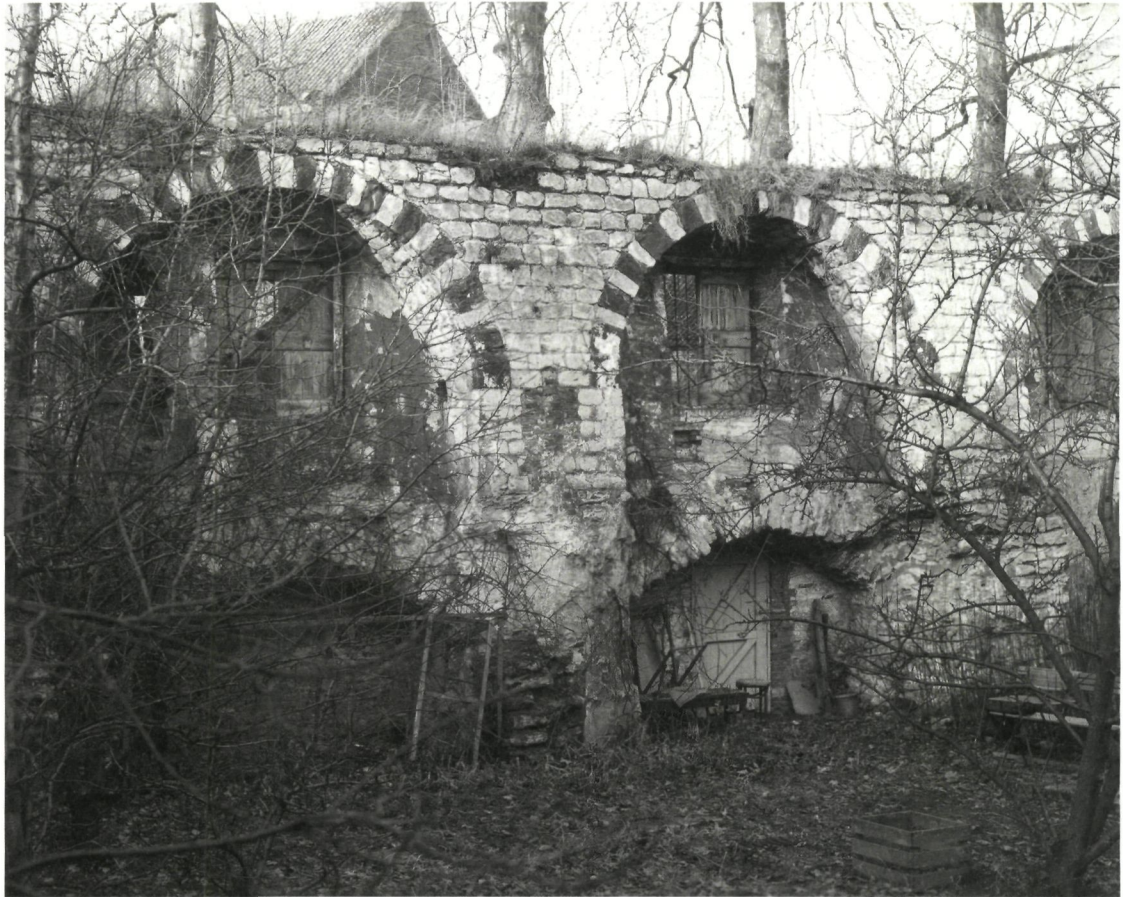
De achterzijde van de stadsmuur met de weergang, rondbogen en vrijgelegde spaarbogen aan de stadzijde (© KIK)
