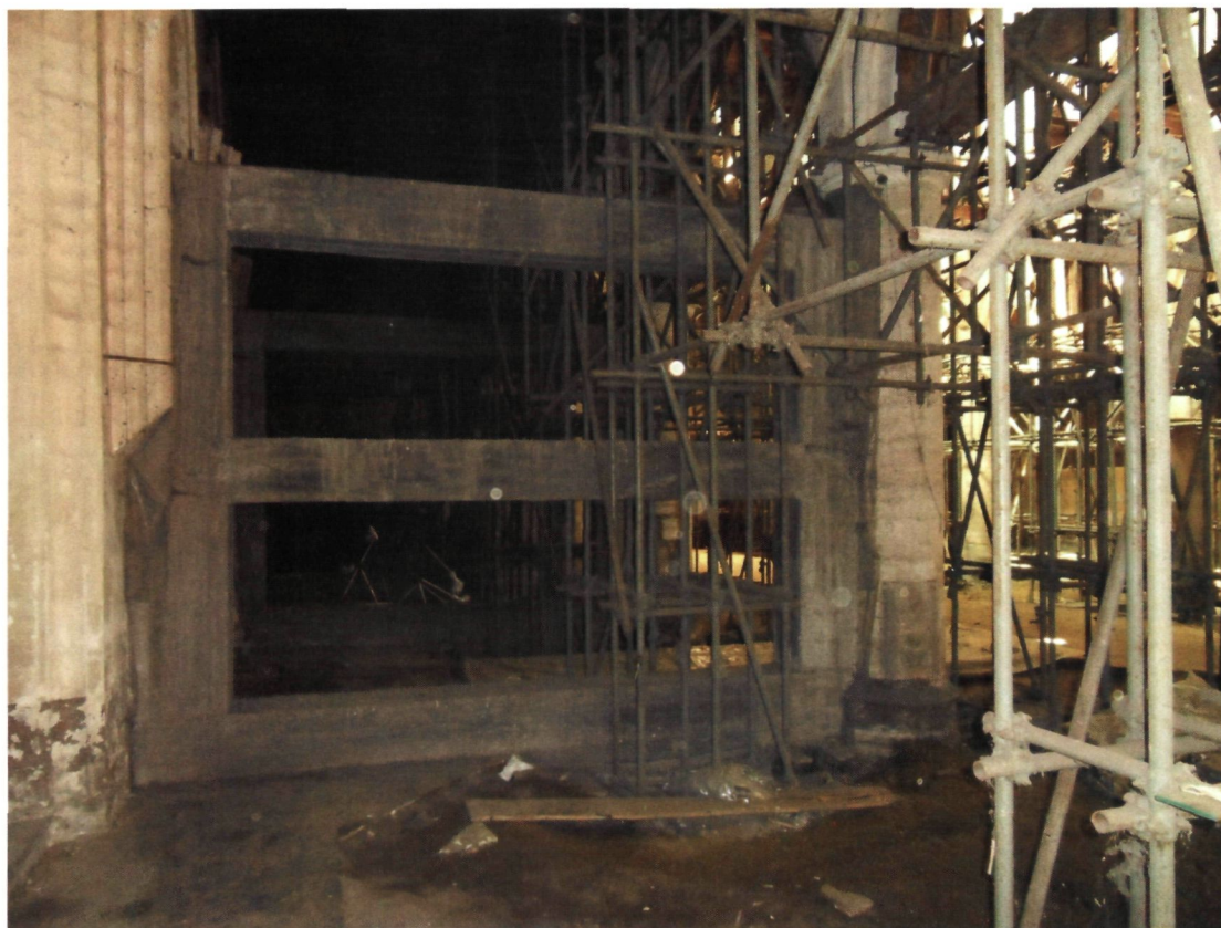
Moderne schoorstructuren in gewapend beton in de zuidelijke zijbeuk van het schip van de Sint-Jacobskerk (foto D. Nuytten)
