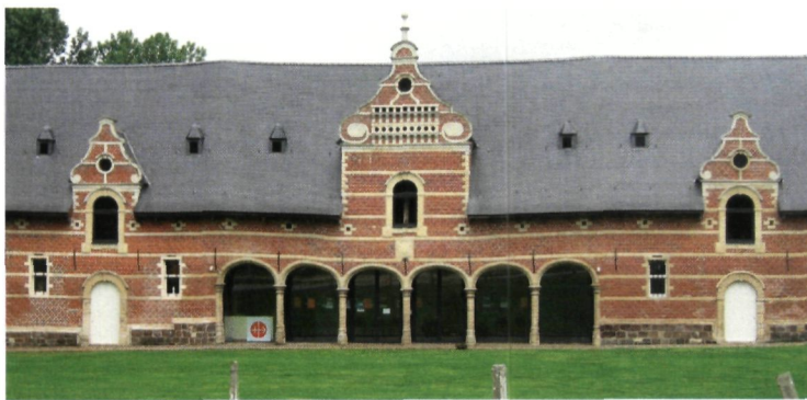
In historische constructies zijn differentieële zettingen een veel voorkomend fenomeen zoals hier in het wagenhuis van de Parkabdij te Heverlee (foto D. Nuytten)
