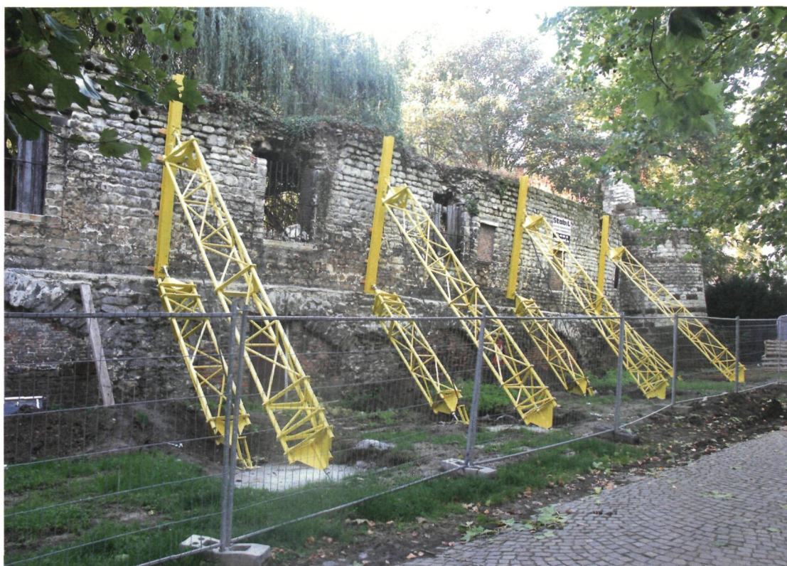
Handbooghof na uitvoering van de schoringswerken in 2006 (foto D. Nuytten)
