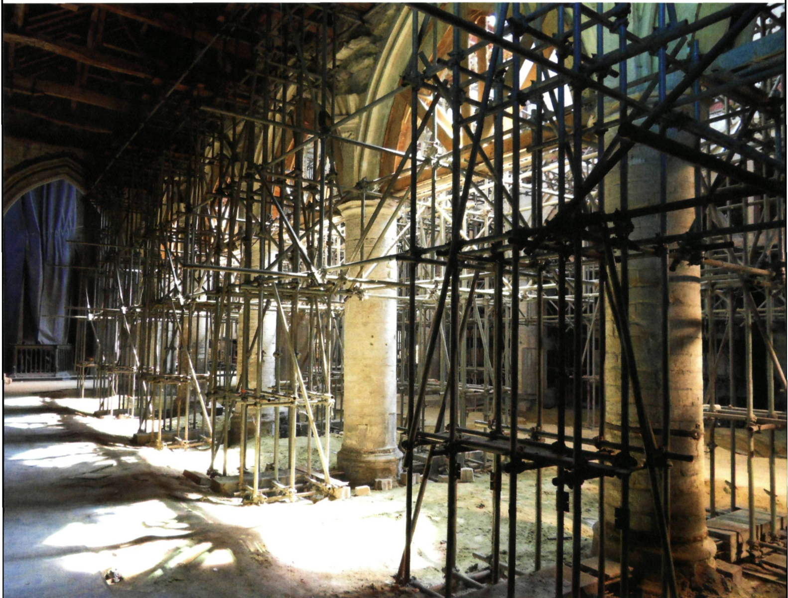
Gezicht op de zijbeuk van de Sint-Jacobskerk waar de gewelven preventief gedemonteerd zijn (foto D. Nuytten)
