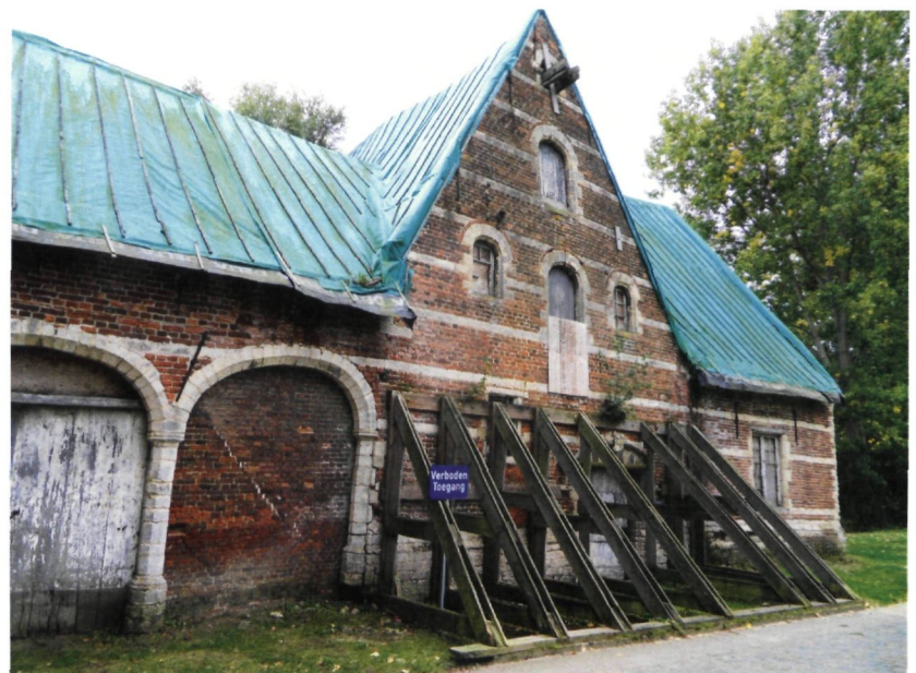
Voorlopige schoring van de gevels aan neerhofzijde (foto D. Nuytten)
