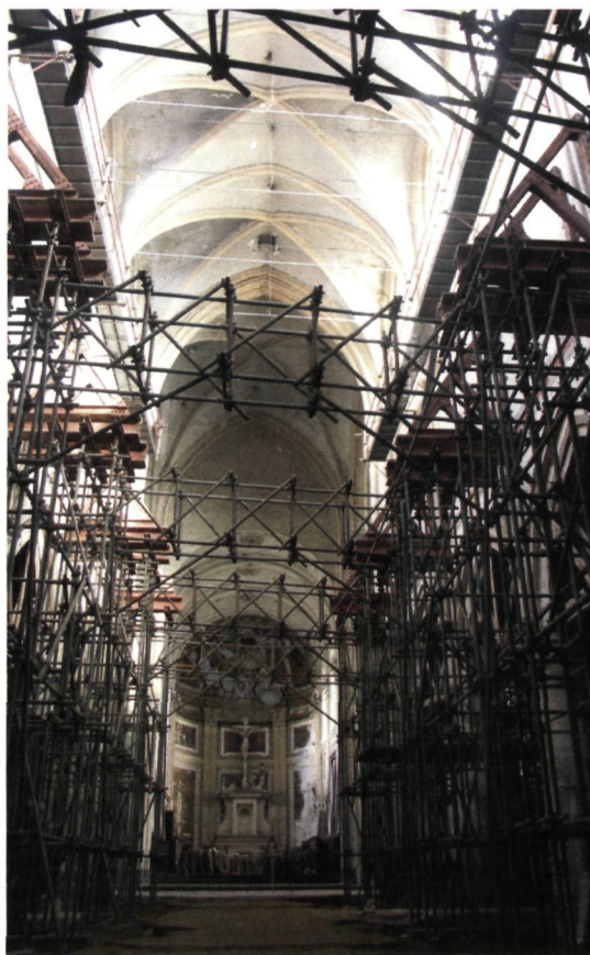
De drastische schoorconstructies verhinderen het hergebruik van het gebouw (foto D. Nuytten)
