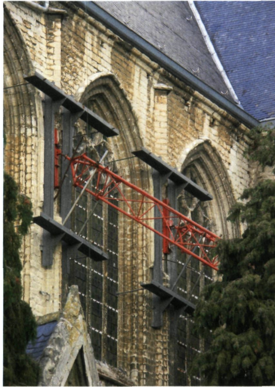
De luchtbogen van de Sint-Jacobskerk werden preventief gedemonteerd: via trekankers werden de spanningen opgevolgd (foto D. Nuytten)
