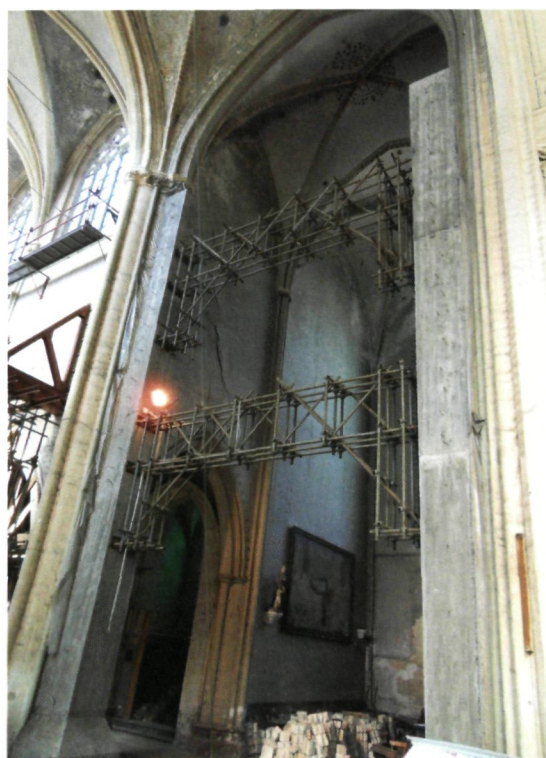
Drastische moderne schorings-constructies in het transept van de Leuvense Sint-Jacobskerk (foto D. Nuytten)
