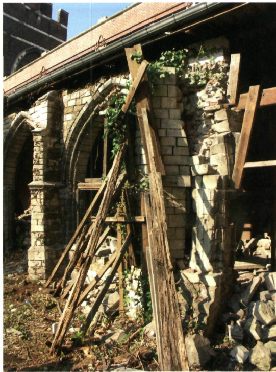
Desintegratie van metselwerk leidt vaak tot instorting, zoals bij de pandgang van de Sint-Geertruiabdij te Leuven (foto D. Nuytten)
