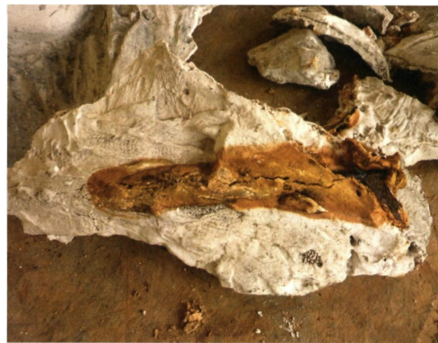
Verkleuring van het gips door verroeste ijzeren wapeningen. Op dit stuk is ook de oorspronkelijke versteviging in jute zichtbaar (foto E. Jacobs)
