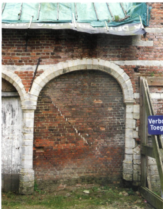
Vervorming van de bogenrij van de watermolen van de Parkabdij in Heverlee (foto D. Nuytten)
