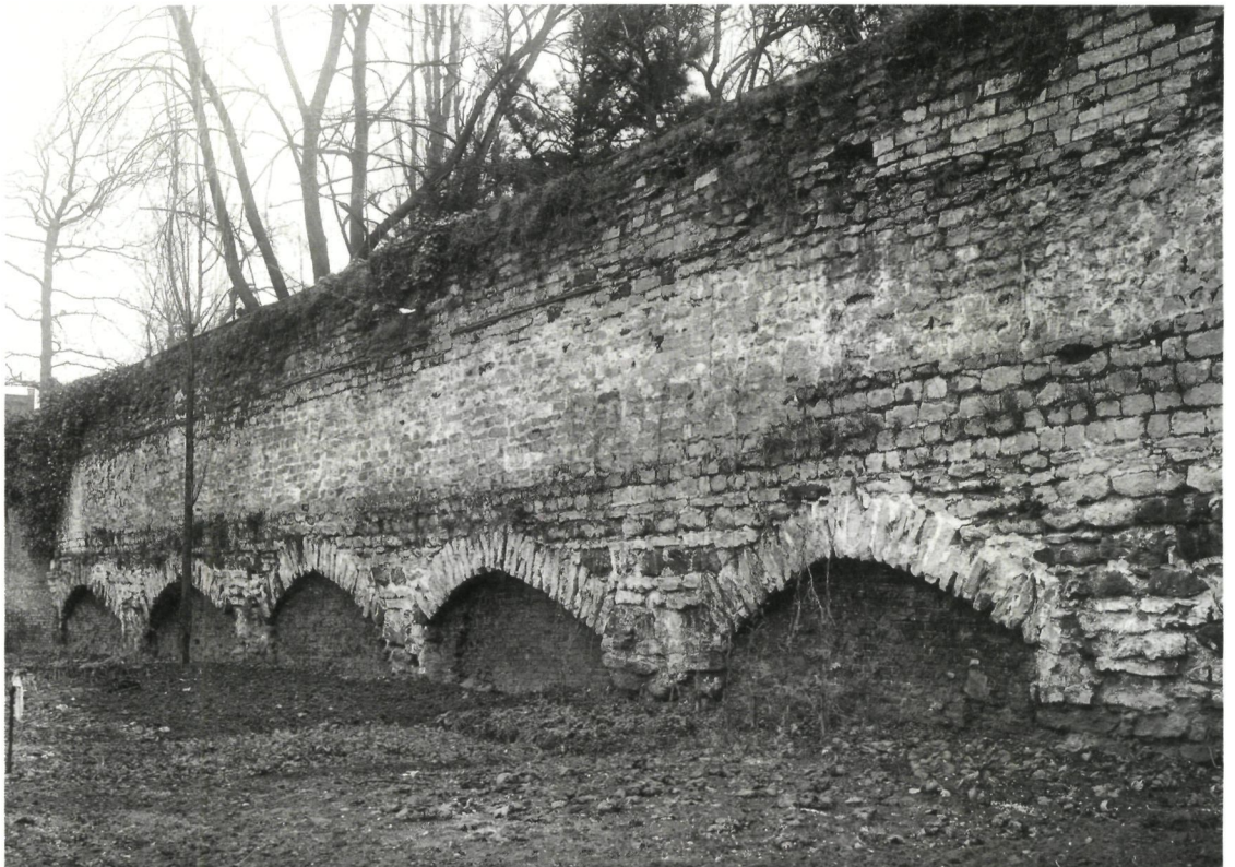
De voorzijde van de stadsmuur: de veldzijde met vrijgelegde spaarbogen (© KIK)
