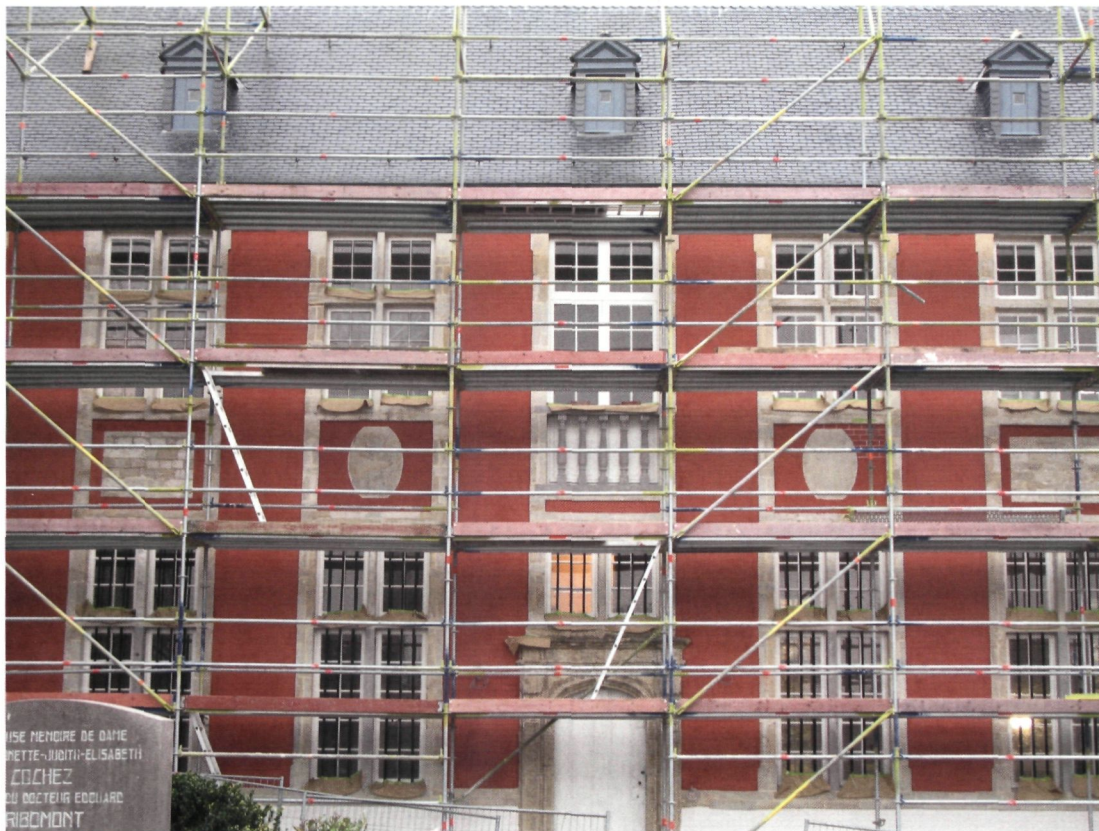
Opnieuw aanbrengen van de laatbarokke afwerking op de noordgevel (foto P. Stevens)
