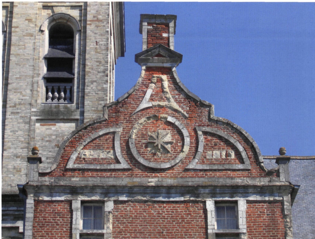
De klokvormige top van de westgevel van het locutorium, toestand vóór de werken (foto P. Stevens)
