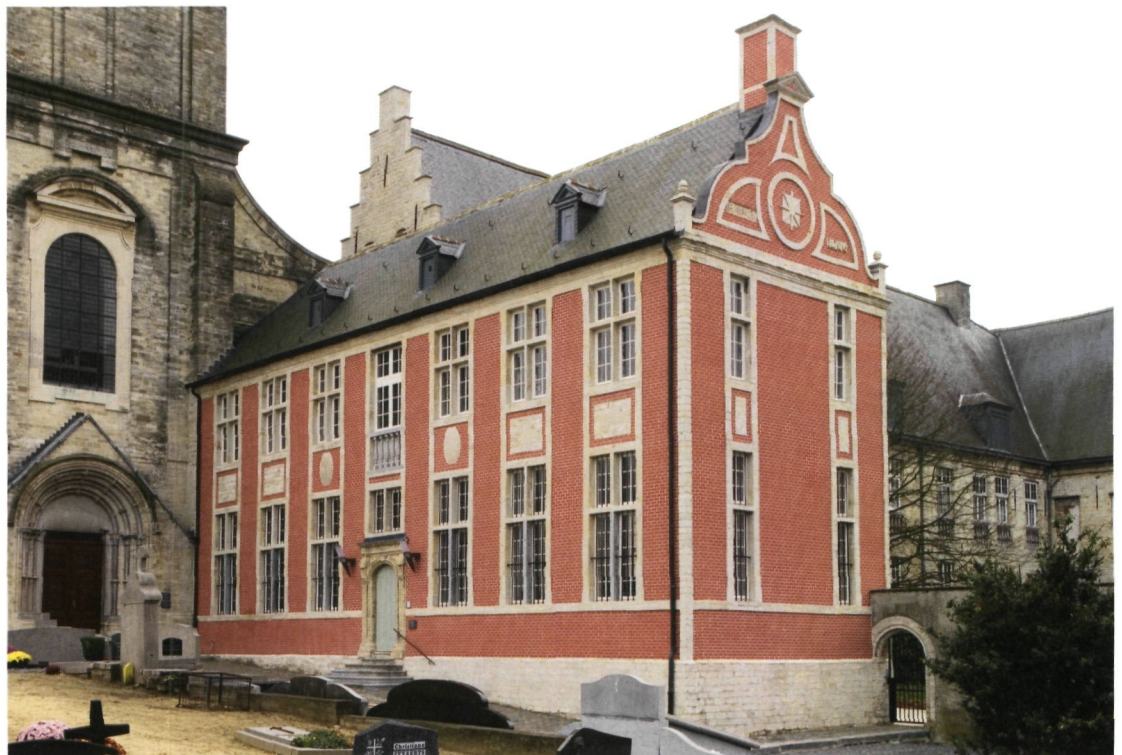
De noordgevel van het locutorium, toestand na de werken (© J. Schoors)
