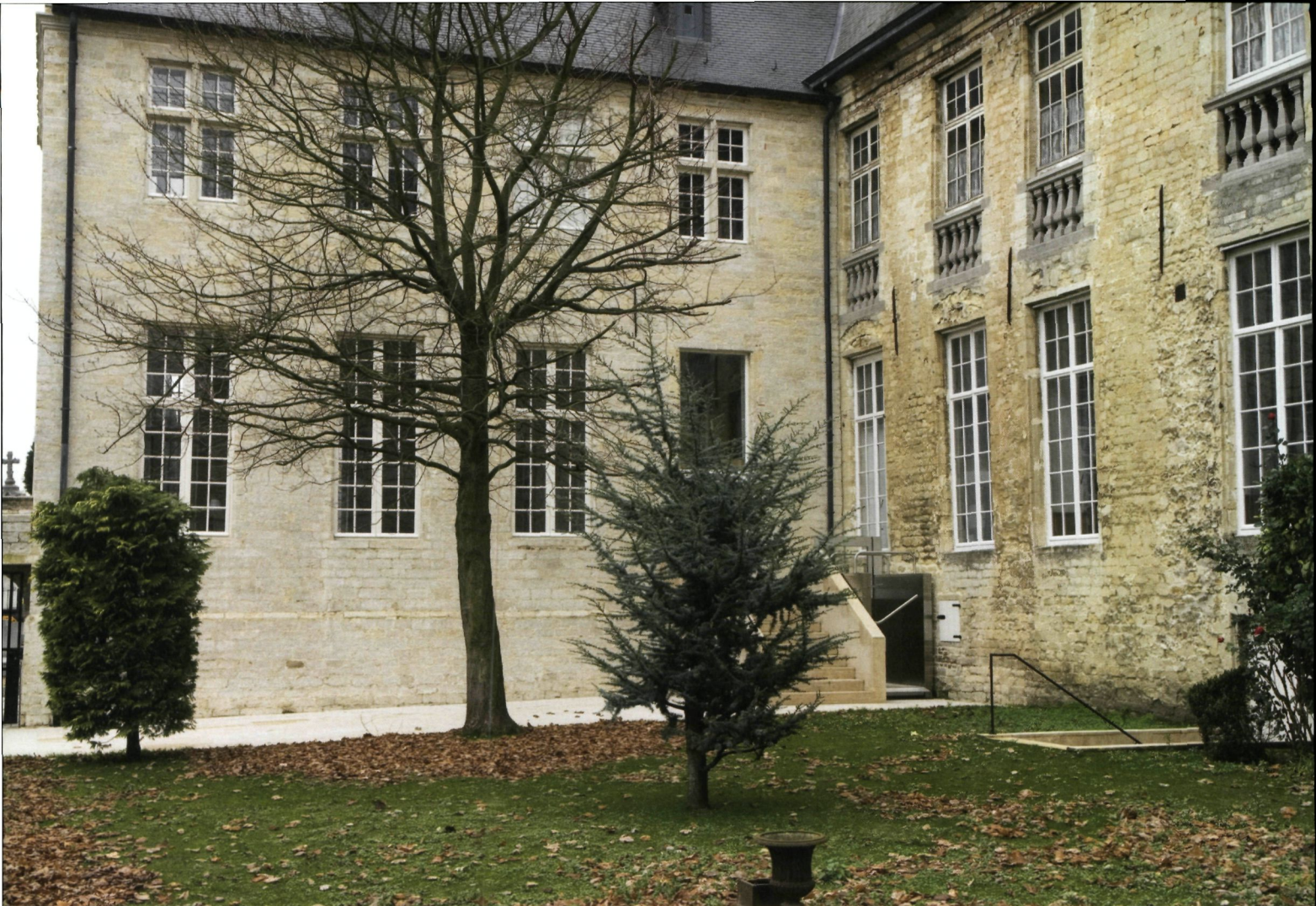
De zuidgevel van het locutorium (© J. Schoors)
