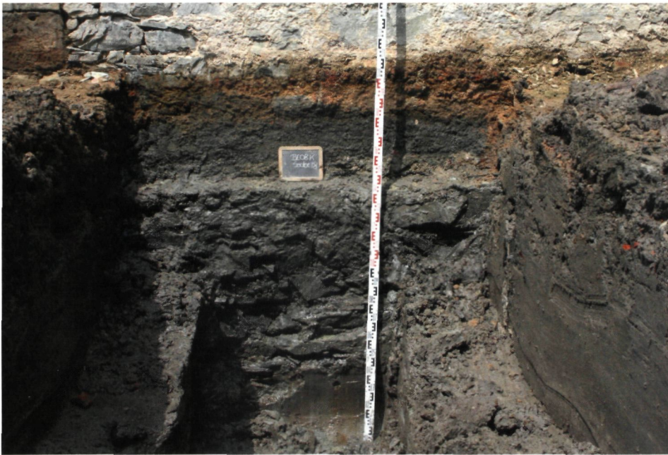
Oostelijke sector van de zuidelijke keermuur: funderingsmuur, opgebouwd uit breuksteen (© Ruben Willaert bvba)
