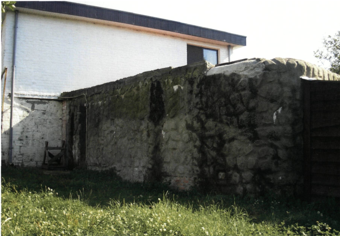
◀ Bunker A44 met een woning aangebouwd (foto Bunkergordel)
