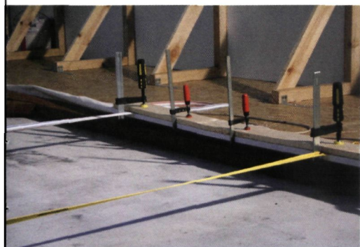
▲ Het opnieuw opspannen van de bedoekte drager met behulp van spanriemen (foto V. Stinckens)
