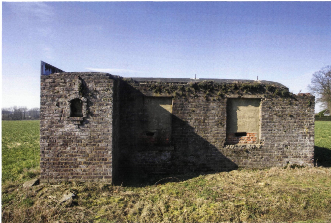
◀ Bunker Av8, gecamoufleerd met baksteen. Een kapelletje is ingemetseld in het oreillon (foto O. Pauwels)
