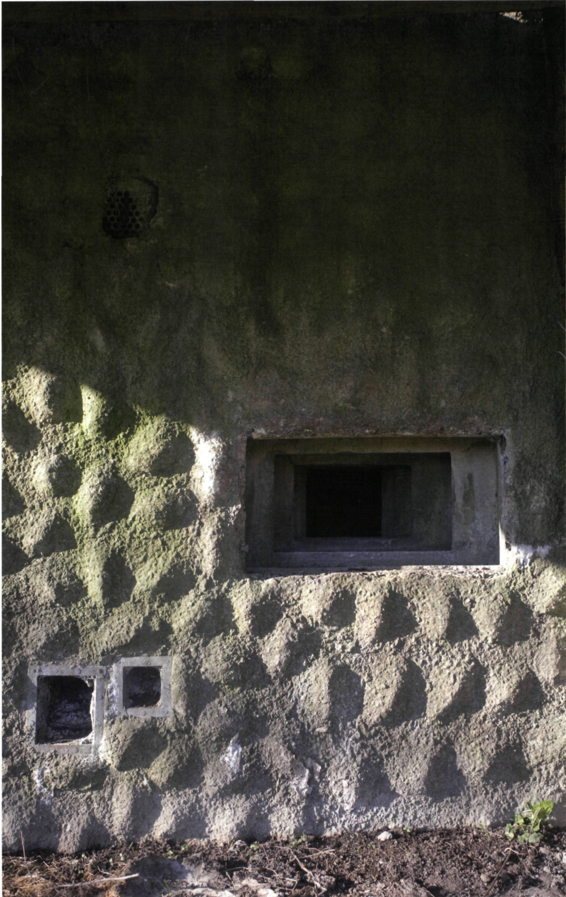
◀ Bunker C18 met als camouflagetechniek Tyrolien Mamelonné (foto O. Pauwels)
