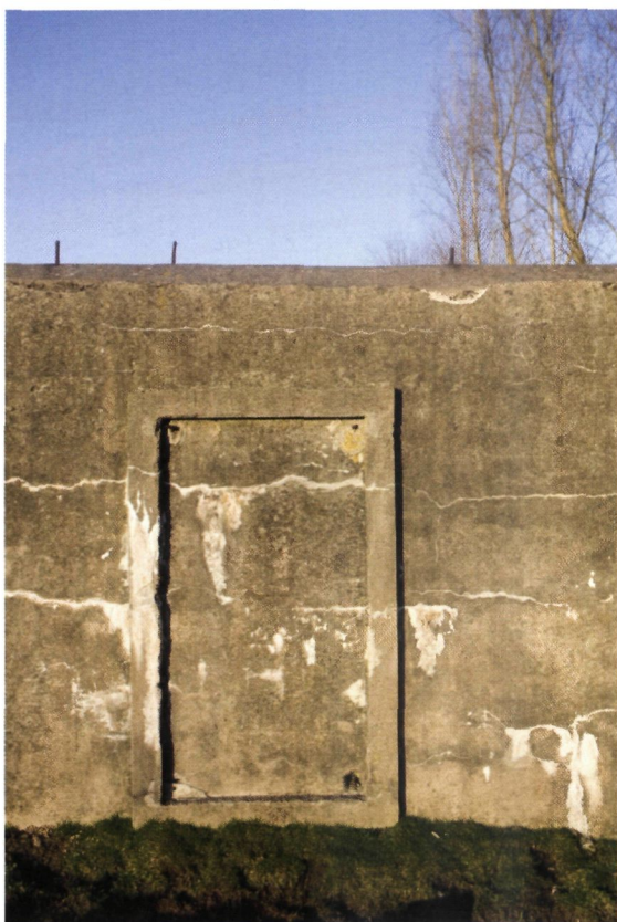
▼ Restanten van camouflage: omlijsting een vals raam of deur (foto O. Pauwels)
