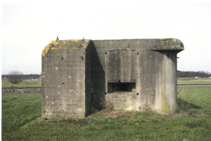
▼ Mitrailleurbunker B9 met enkelvoudige kamer (foto O. Pauwels)
