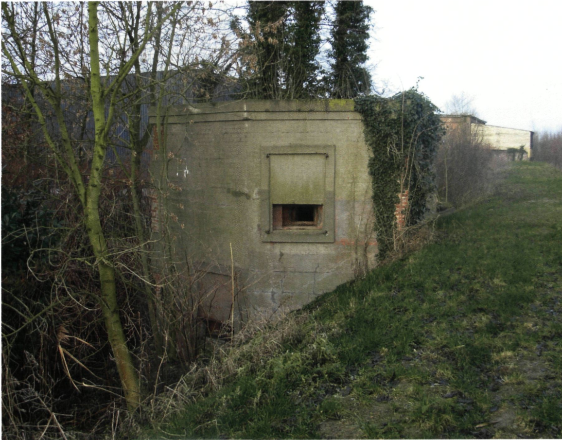
◀ Speciale bunker met twee verdiepingen (foto Bunker gordel)
