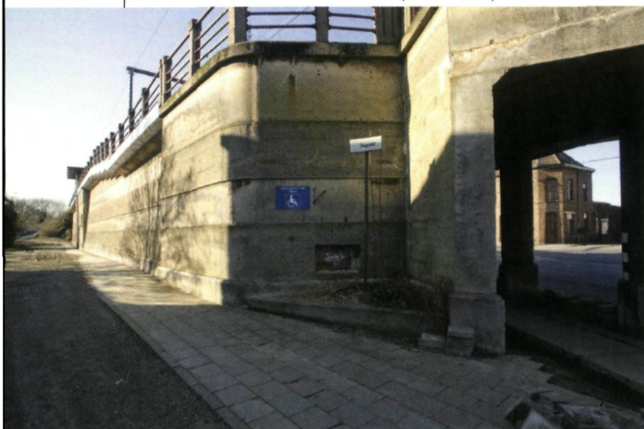
▼ Bunker D22 in de hoek van een spoorwegviaduct (foto O. Pauwels)
