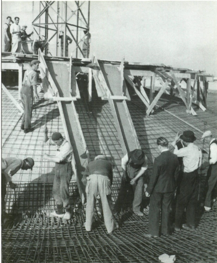
▲ Eigentijdse foto tijdens de bouwverf: het gieten van het beton (uit: STRAUVEN I., o.c., p.29)
