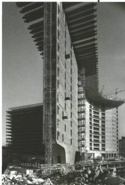
Het Berlaymont in opbouw, Lucien De Vestel, 1959-1967 © AAM
