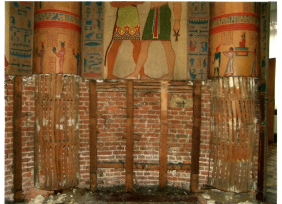
▼ Voór restauratie. Toestand na demontage van de onderste trommels en lambrisering (foto H. Vandenborre)
