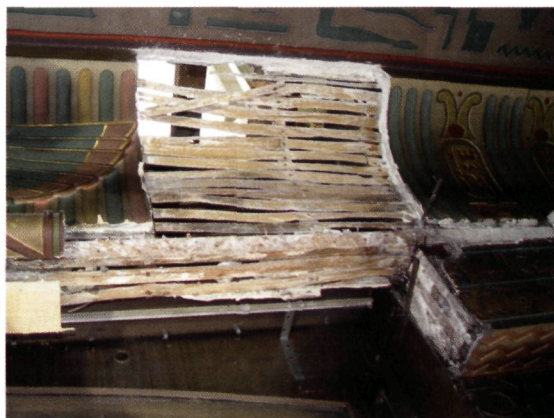
◀ Demontage van de kooflijst nodig voor de vervanging van het raamlinteel (foto H. Vandenborre)
