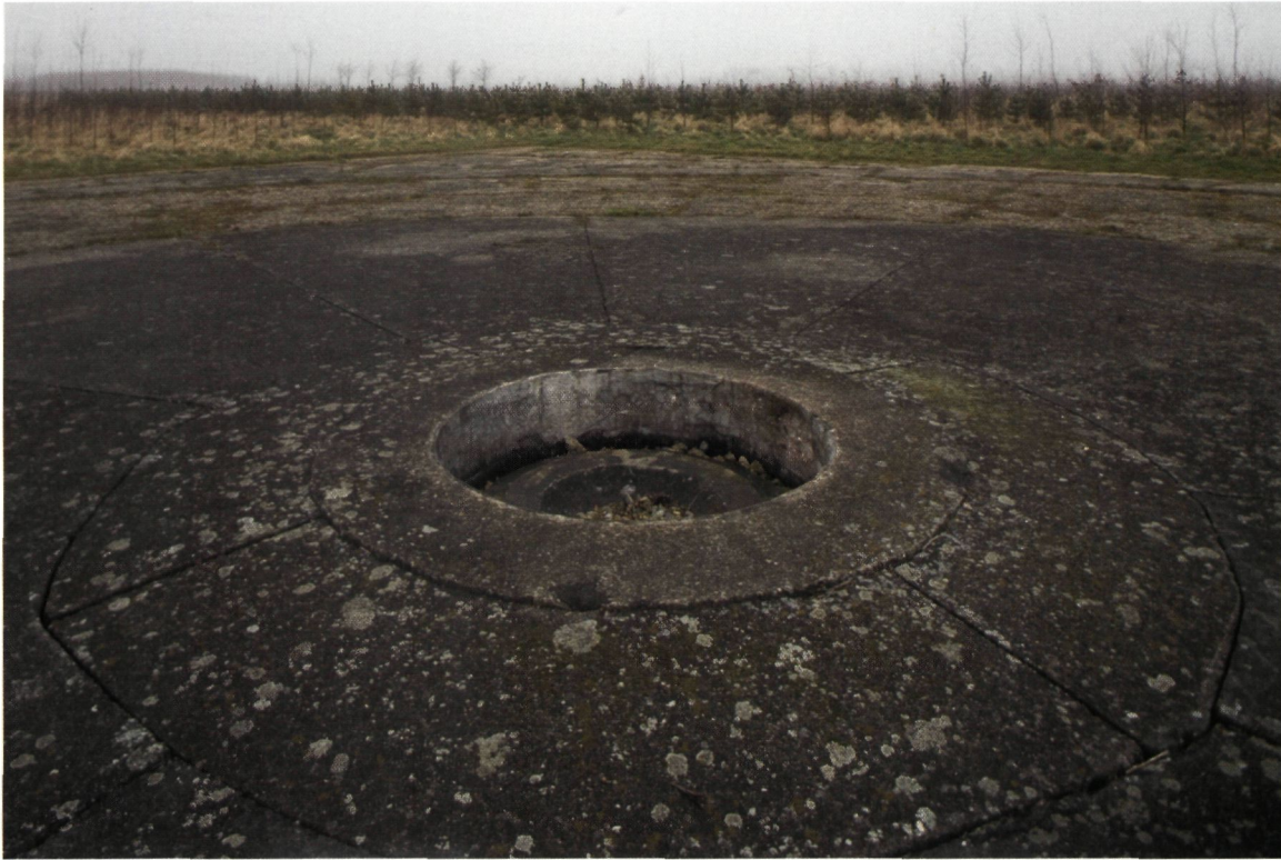
◀ Zicht op de centrale put van de compenseerinrichting waarin oorspronkelijk de glazen bollen werden geplaatst (foto O. Pauwels)
