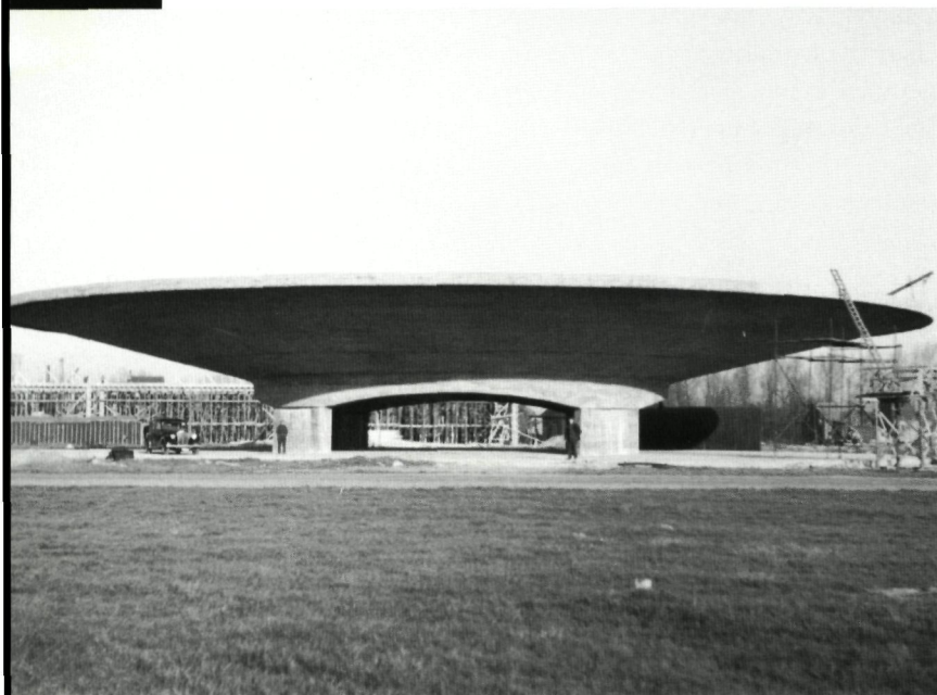
▲ Eigentijdse foto tijdens de bouwwerf: toestand na het ontkisten (collectie vakgroep Architectuur en Stedenbouw, UGent)
