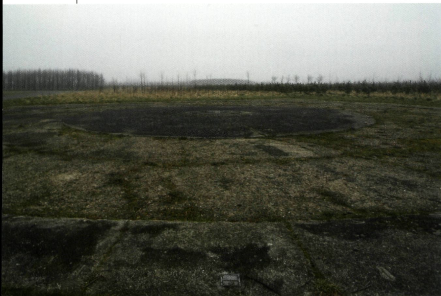
▼ Globaal zicht op de compenseerinrichting in Grimbergen. Op de periferie van de betonnen schijf zijn messing plaatjes aangebracht met gradenaanduiding (foto O. Pauwels)
