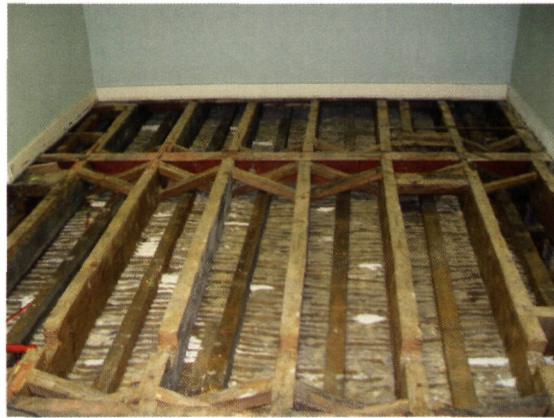
◀ Plafondopbouw met houten roostering en stalen I-profielen (foto H. Vandenborre)
