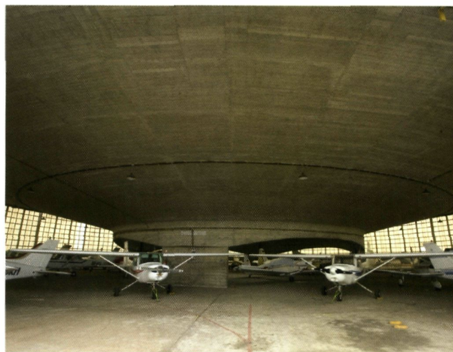
▲ De centrale ruimte van de paddenstoelconstructie (foto O. Pauwels)
