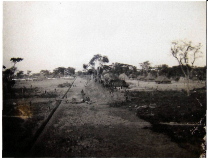
▲ Aanleg van een weg van de Commune Albert I, 1921 (AAM, Brussel)
