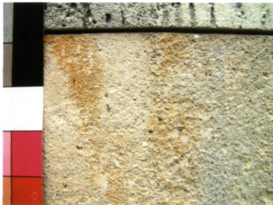
► Puncties en stratigrafie op de oudste afwerkingslagen van de pleister
