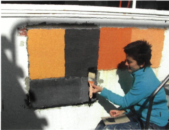
▲ Proefrestauratie door Examino cvba en Profiel cvba: het zwart wordt bekomen door fresco te schilderen op de natte, in de massa gekleurde pleister
