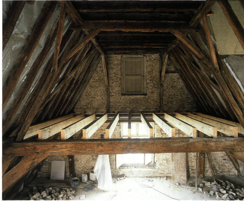
▲ Jan van Eyckplein 8: de sporenkap uit het midden van de 15 de eeuw (foto O. Pauwels)
