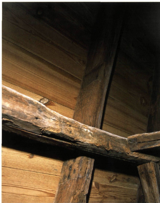
◀ Jan van Eyckplein 8: hergebruikt dakspoor uit 1225-1240 met telmerk 25 (foto O. Pauwels)
