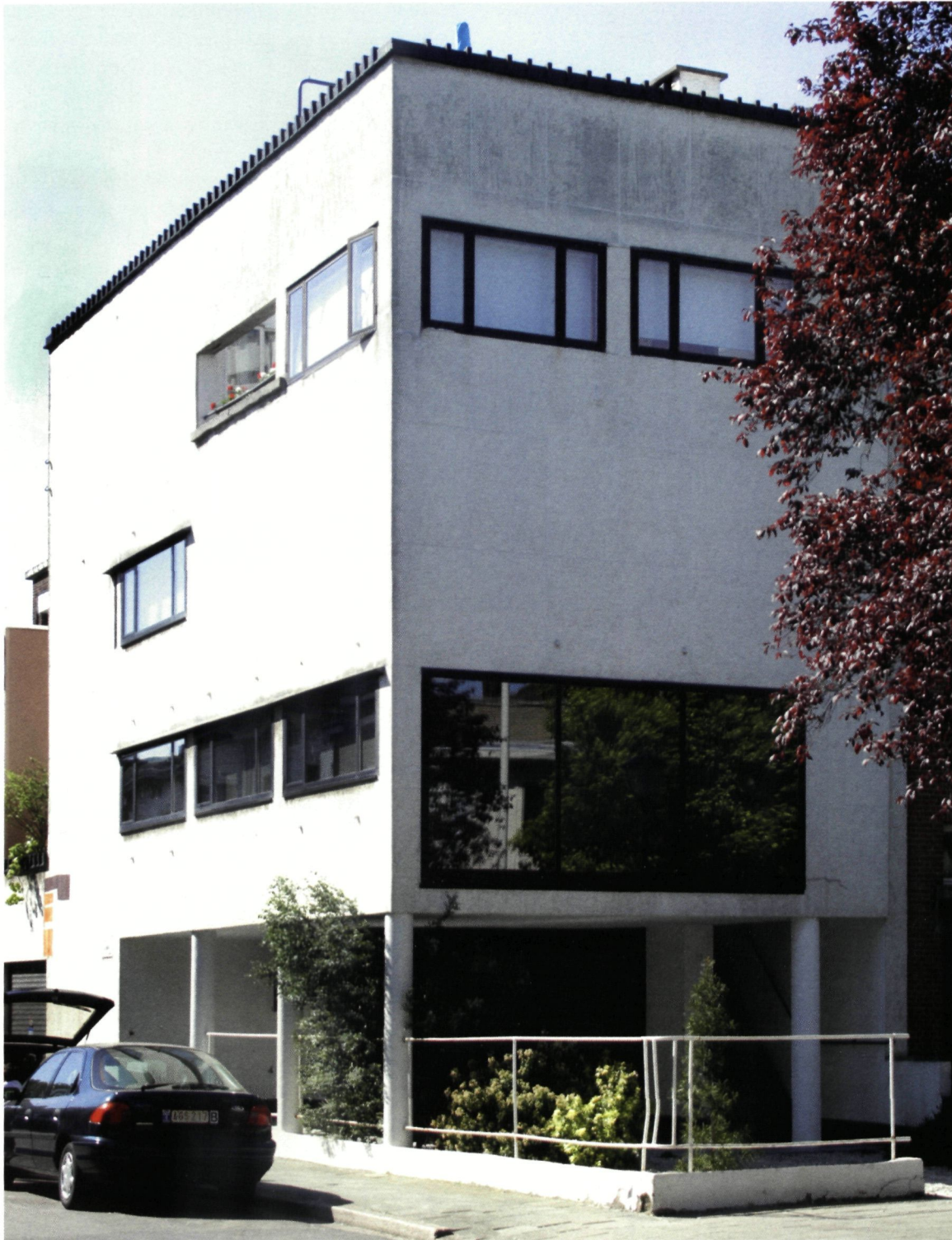
◀ Woning Peeters in Deurne, buitenaanzicht (foto O. Pauwels)
