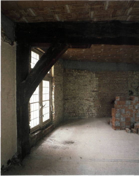
▲ Jan van Eyckplein 8: korbeelstel op de eerste verdieping (foto O. Pauwels)
