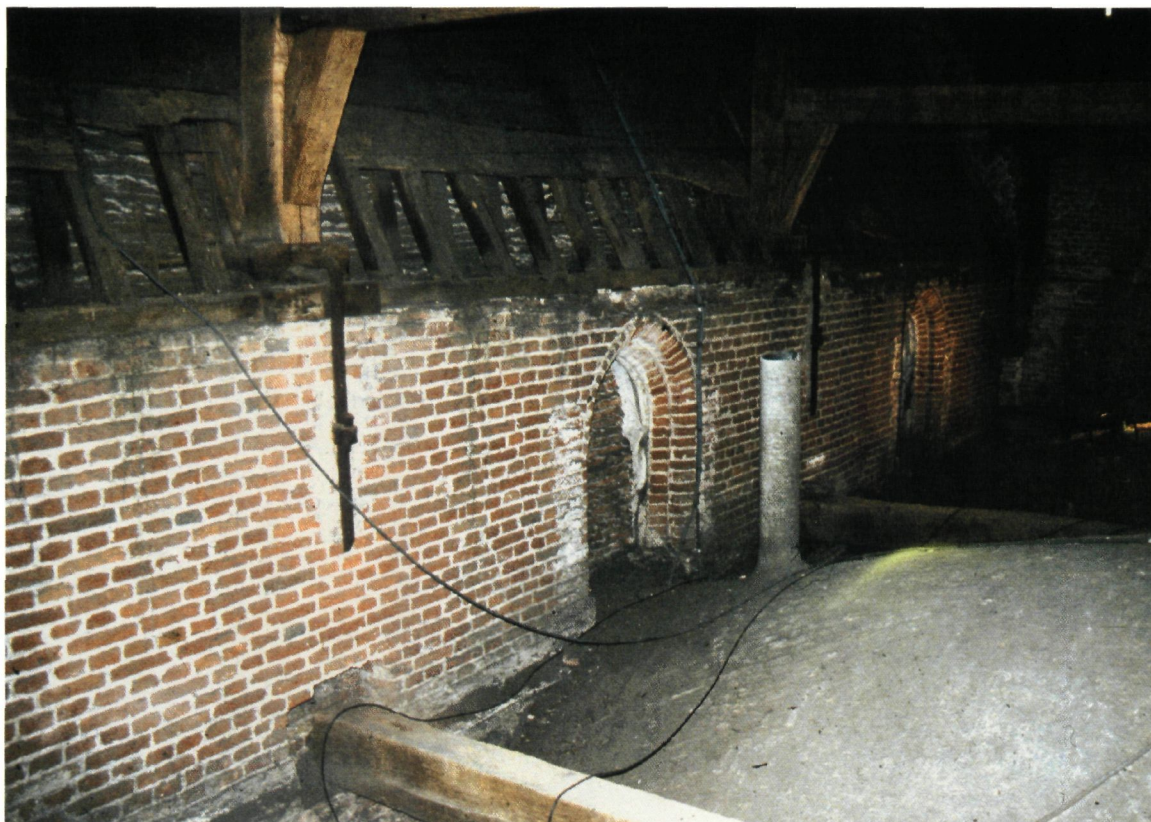
◀ Het interdisciplinaire onderzoeksproject van de deelgemeente Sint-Kruis-Winkel omvatte ook archeologische aspecten zoals de registratie van muursporen tussen de gewelven en de dakkap van de Heilig-Kruiskerk: daar bleven immers de oudste, nog niet beroerde of herstelde sporen bewaard van een unieke gotische kerk uit het landelijke gebied ten noorden van Gent (foto Stad Gent, dienst Stadsarcheologie)
