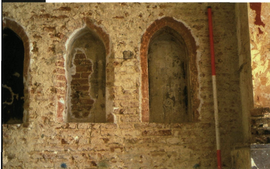
▲ De gotische muurnissen in het huis aan de Zakstraat (L. Troubleyn, Stad Mechelen, 2003)
