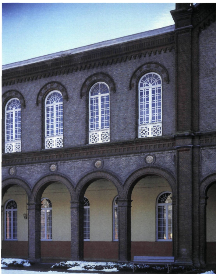
▲ Gevel van de binnenkoer in eclectische stijl (foto K. Vandevorst)
