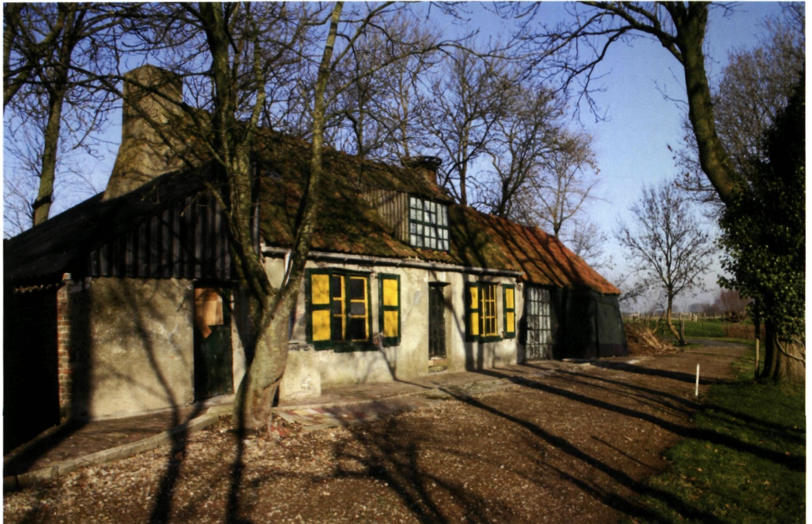
► De 17 de -eeuwse sluiswachterswoning aan de Zwarte Sluis; zuidgevel (foto O. Pauwels, 2006)
