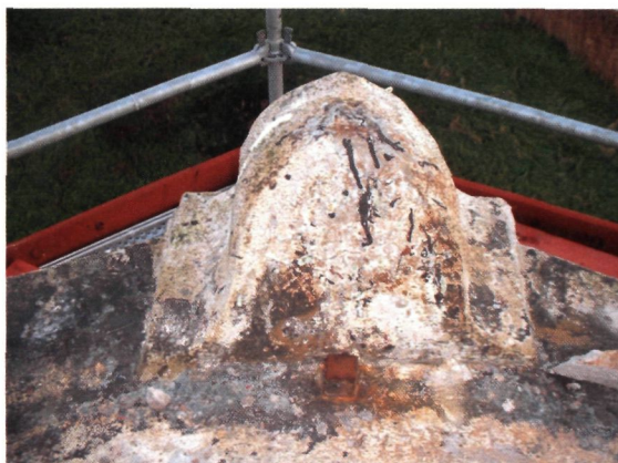
◀ Detail van de voet van de balustrade van het Hoog Licht, dat model stond voor de reconstructie (Didier Vannieuwenburg)
