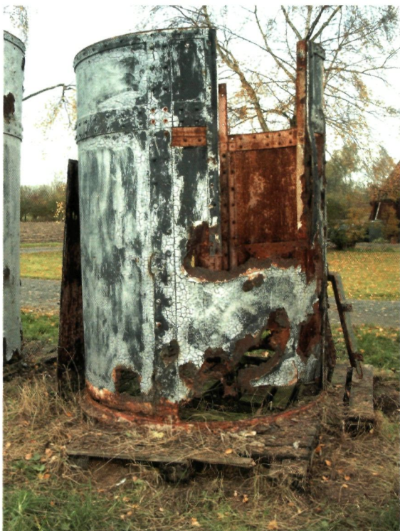
▶ De lantaarn van het Hoog Licht, toestand na demontage (Didier Vannieuwenburg)
