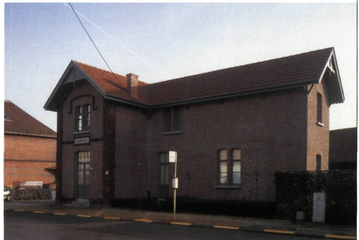
▼ Het tramstation in Grimbergen (Humbeek), herbestemd tot ééngesinswoning (foto O. Pauwels)
