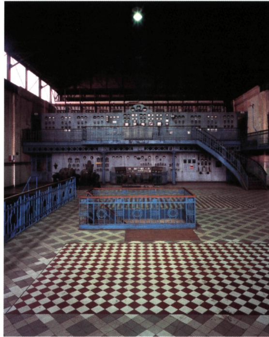
▲ Winterslag, de compressoreenzaal (foto K. Vandervorst)
