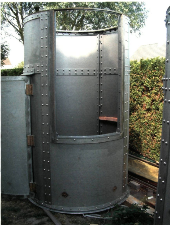
► Het nieuw lampenhuis van het Laag Licht, waarbij de klinknageltechniek werd aangewend (Didier Vannieuwenburg)
