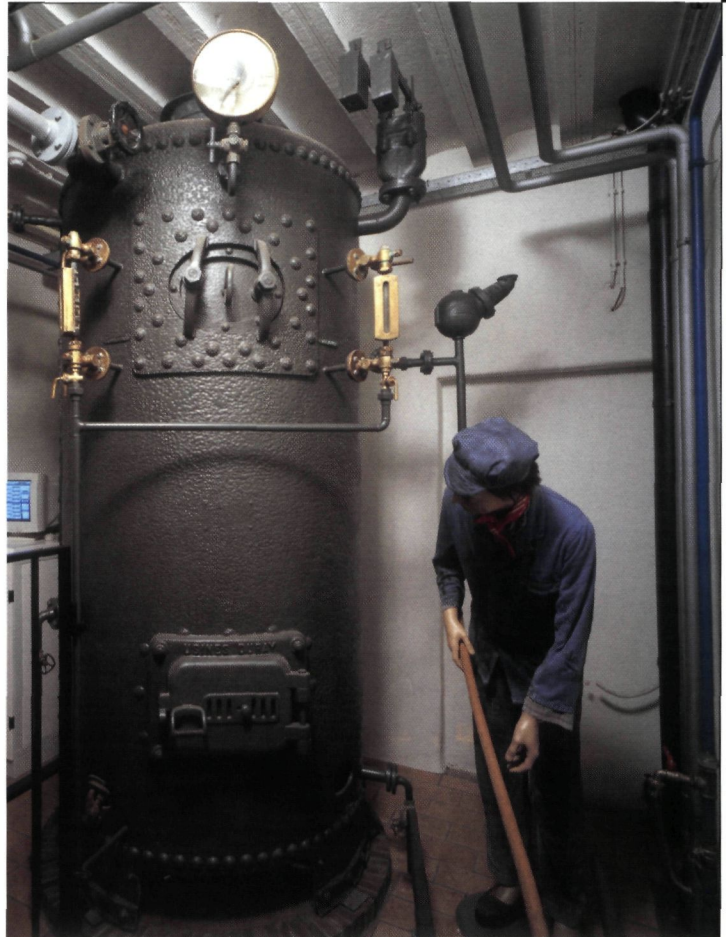
▲ De stoomketel in de stookruimte zorgde via een netwerk van leidingen voor de warmtetoevoer naar verschillende machines, zoals de melkpasteur (foto O. Pauwels)
