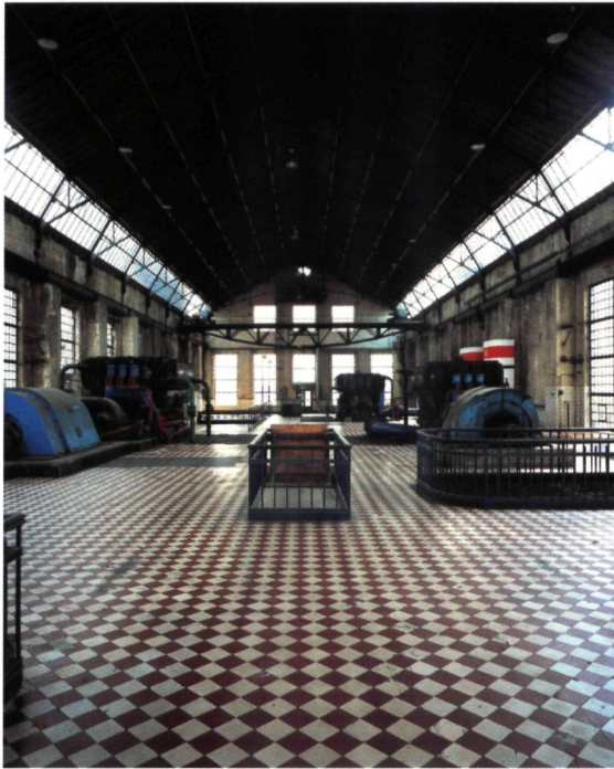
▲ Winterslag, de electriciteits- centrale (foto K. Vandervorst)
