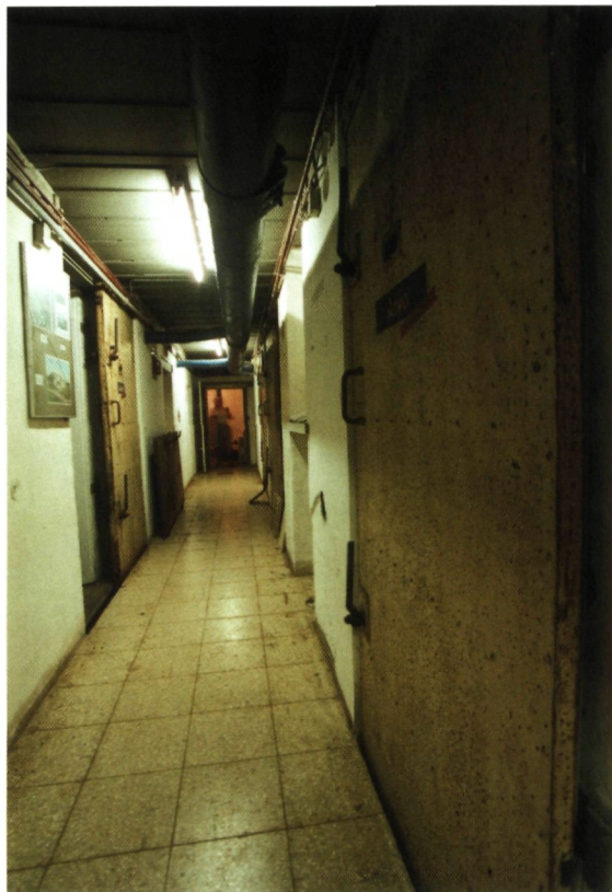
▲ De centrale gang van de commandobunker met de originele schuifdeuren (foto auteur)
