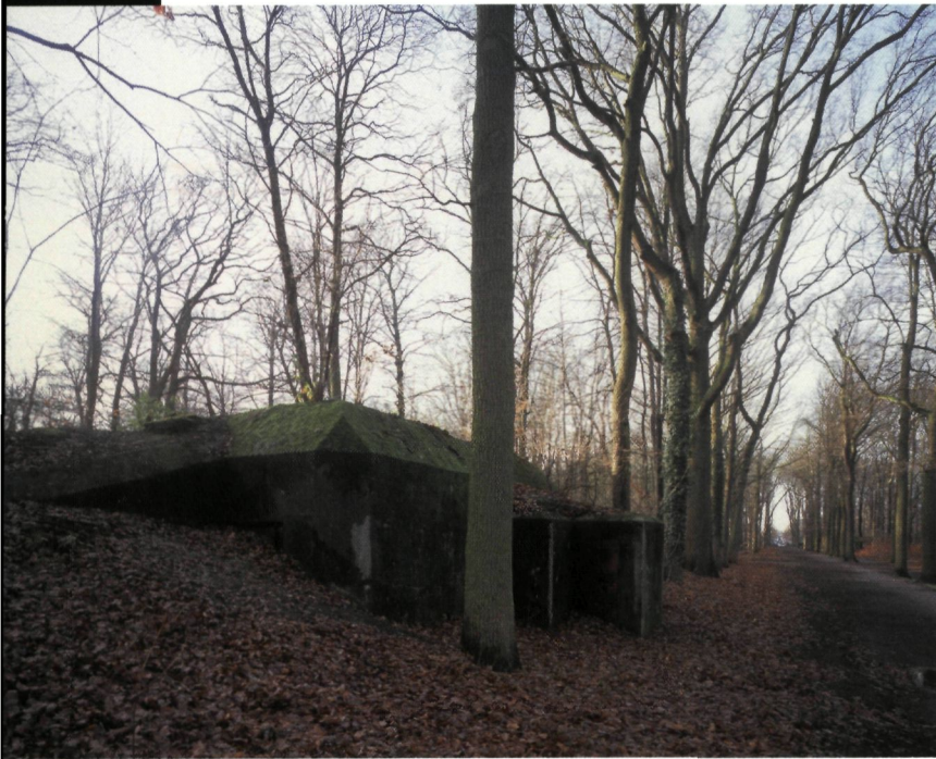
▲ De manschappenbunker type 52a met kleine aanbouw (foto O. Pauwels)
