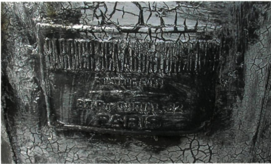
► Identificatieplaat van de lampeninstallateur op de lantaarn van het Hoog Licht, vóór restauratie (Driesen-Meersman-Thomas architecten)
