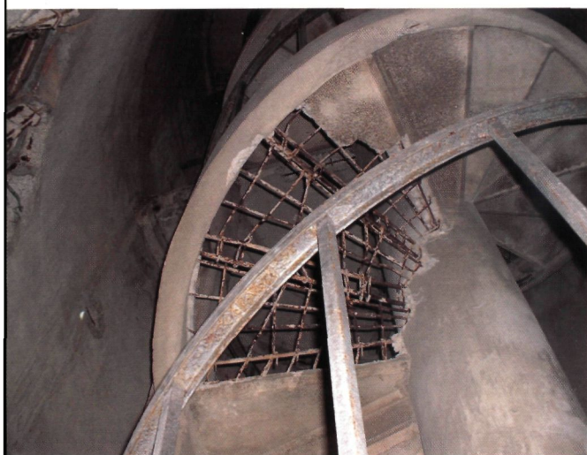
◀ Interieur van het Hoog Licht tijdens de restauratie (Didier Vannieuwenburg)
