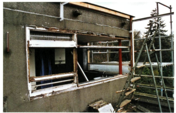
▲ Badkamergevel: bestaande toestand
