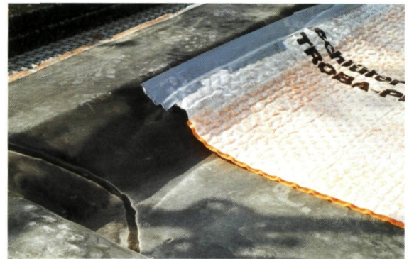
▲ Detail opkragen drainagemat aan kim (dakrand)
