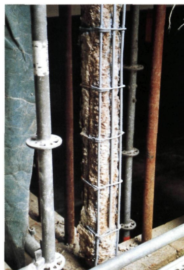
▲ Corrosiebescherming van de wapening
