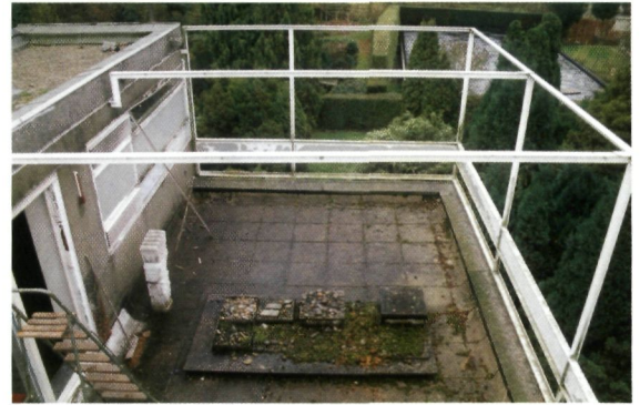
▲ Terras tweede verdieping: bestaande toestand
