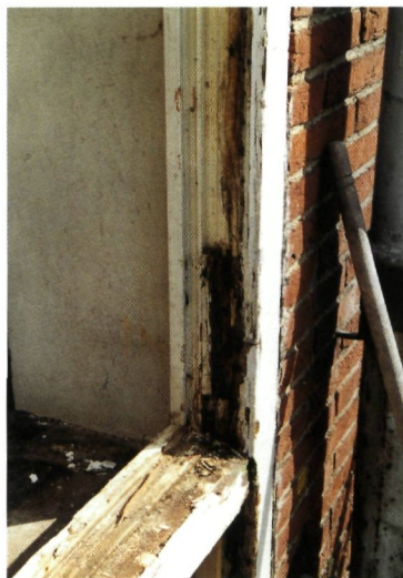
▼ Raam bibliotheek na demontage van de beglazing; aan de profilering en inkeping voor de scharnieren is merkbaar dat dit oorspronkelijk een open opendraaiend raam was
