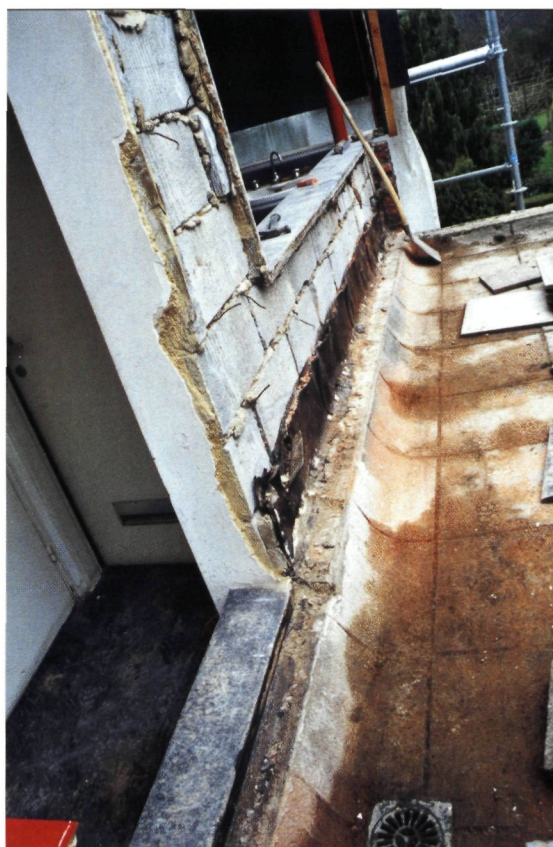
◀ Terras tweede verdieping na demontage van het gevelparement
