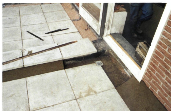
▲ Aanwerken kim betonbalk en muren
