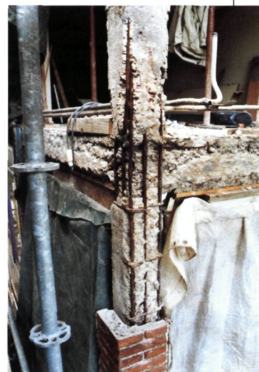
▼ Hoekkolom en vloerplaat op de eerste verdieping
