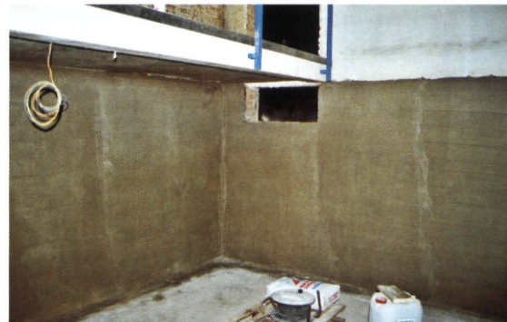
◀ Atelier hoek ZO: waterdichte cementering
