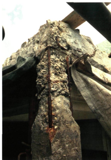
▼ Hoekkolom eerste verdieping aan- sluiting met vloer- plaat terras
