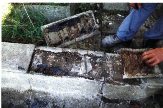
◀ Terras tweede verdieping: omgekeerde betonbalk samenstelling Solar-bekleding
