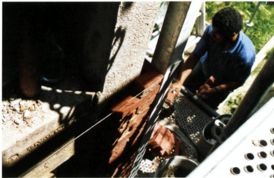
► Metselwerkbekleding na herstel van de kolom
