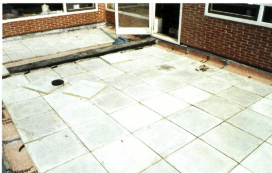
► Terrastegels op drainagelaag
