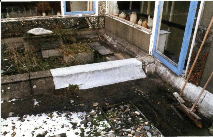
▲ Terras tweede verdieping: omgekeerde betonbalk deels afgedekt met loodslabbe
