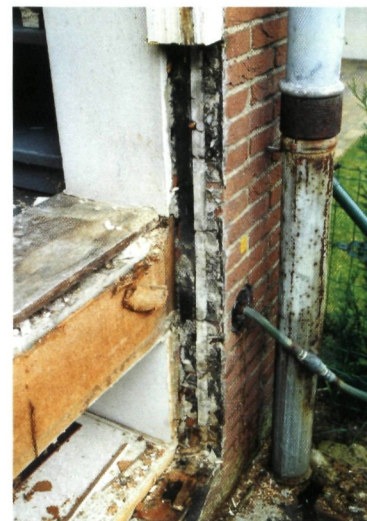
▼ Proefdemontage raam: bemerk de isolatiebanden tussen kader en metselwerk en de strook mortel ertussen
