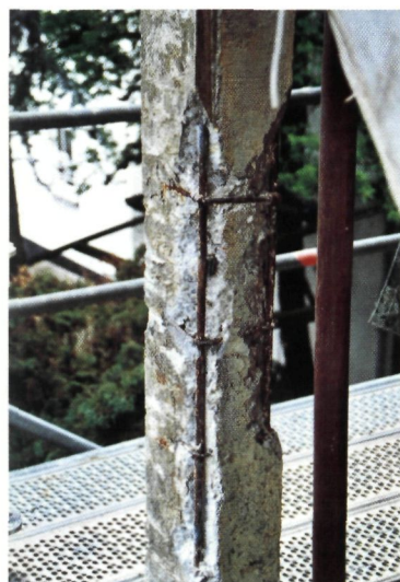
▲ Aangetast beton wordt verwijderd
