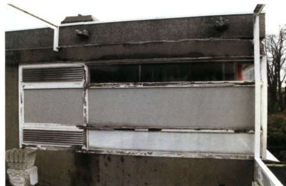
▲ Badkamergevel: toestand voor de restauratie
