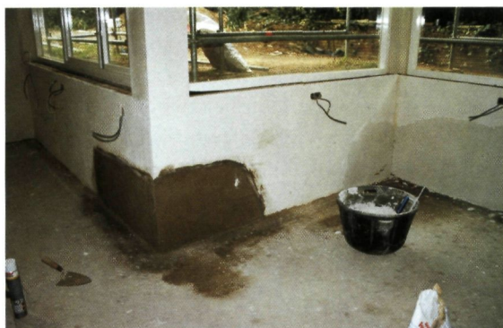
► Atelier: herstellen van de waterdichting
