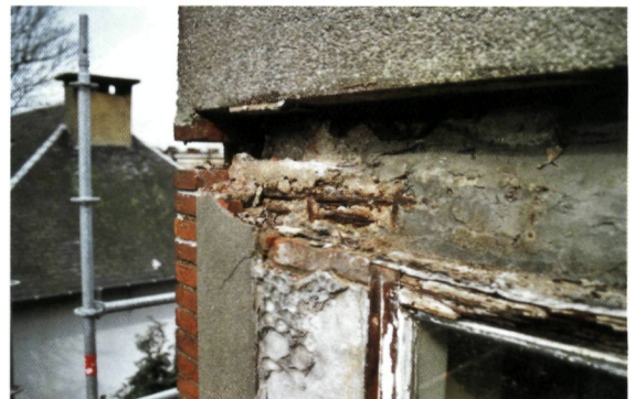
▼ Slaapkamergevel na het verwijderen van het parement
