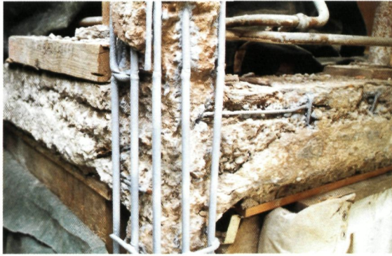
► Herstel van de wapening
