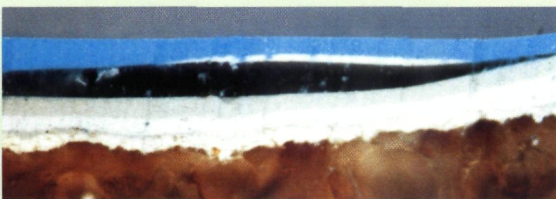
▲ Dwarsdoorsnede van het verflagenpakket aangetroffen op het draairaam in de voorgevel ter hoogte van het atelier (foto Marc Deviaene, Akzo Nobel)
