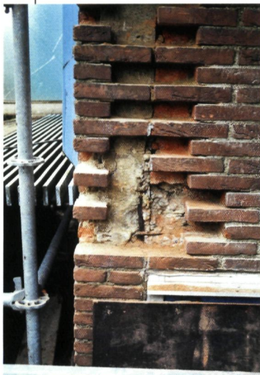
▲ Hoekkolom aan garage
