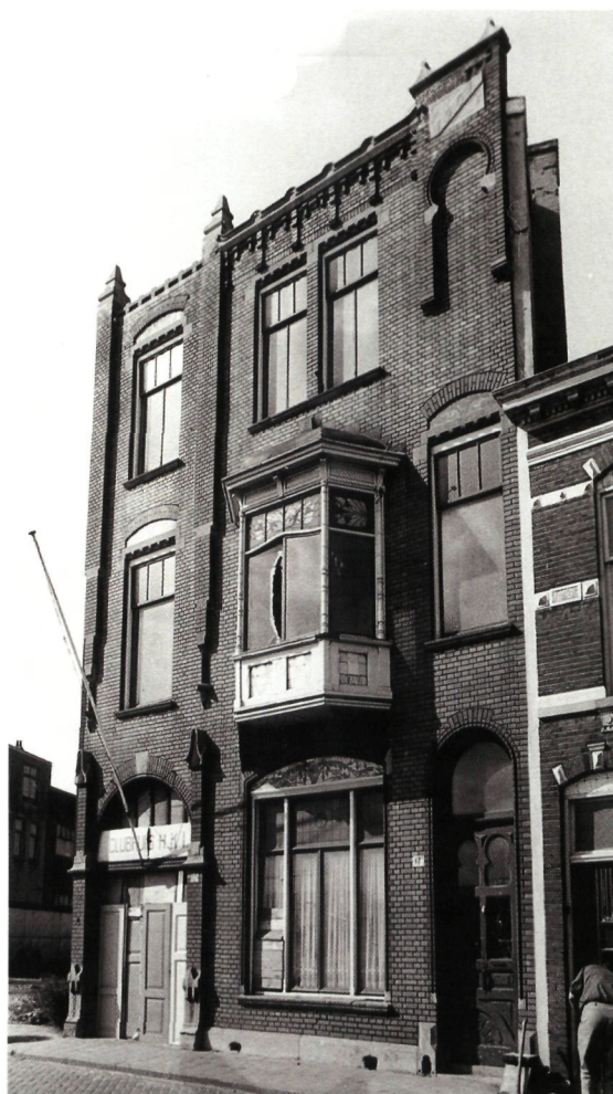
◀ Het gebouw van N.V. Industriële Maatschappij F.J. Stulemeijer & Co, gebouwd in 1901 in fraaie Art-Nouveaustijl in het industriegebied ten noorden van Breda. In 1909 richtten de gebroeders Stulemeijer de Société Belge des Bétons op, die in Brussel belangrijke werken heeft aangelegd (Foto: B. Speekenbrink, Breda, 1967 - Collectie Stadsarchief Breda)
