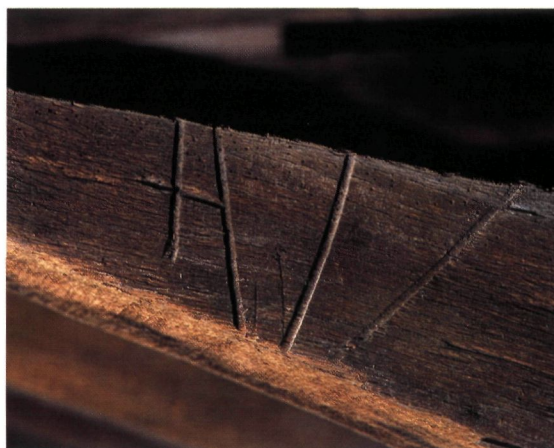
◀ Academiestraat 3. Dakkap met spits- booggewelf. Eigendomsmerk op één van de hanebalken (foto O. Pauwels)
