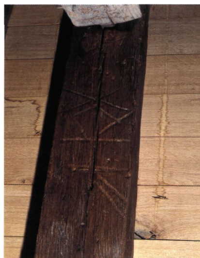
◀ Academiestraat 1. Detail van één van de daksparren met bovenaan een eigendomsmerk en vlak eronder het telmerk '10' (foto O. Pauwels)
