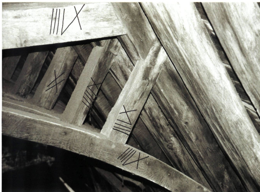
► Academiestraat 3. Telmerken in de dakconstructie met spitsbooggewelf (foto auteur)
