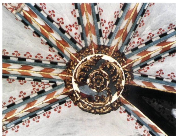
▲ Sluitsteen in het koorhoofd. Rechtsonder is nog de roetlaag zichtbaar die de gewelven volledig bedekte (foto K. Breda)
