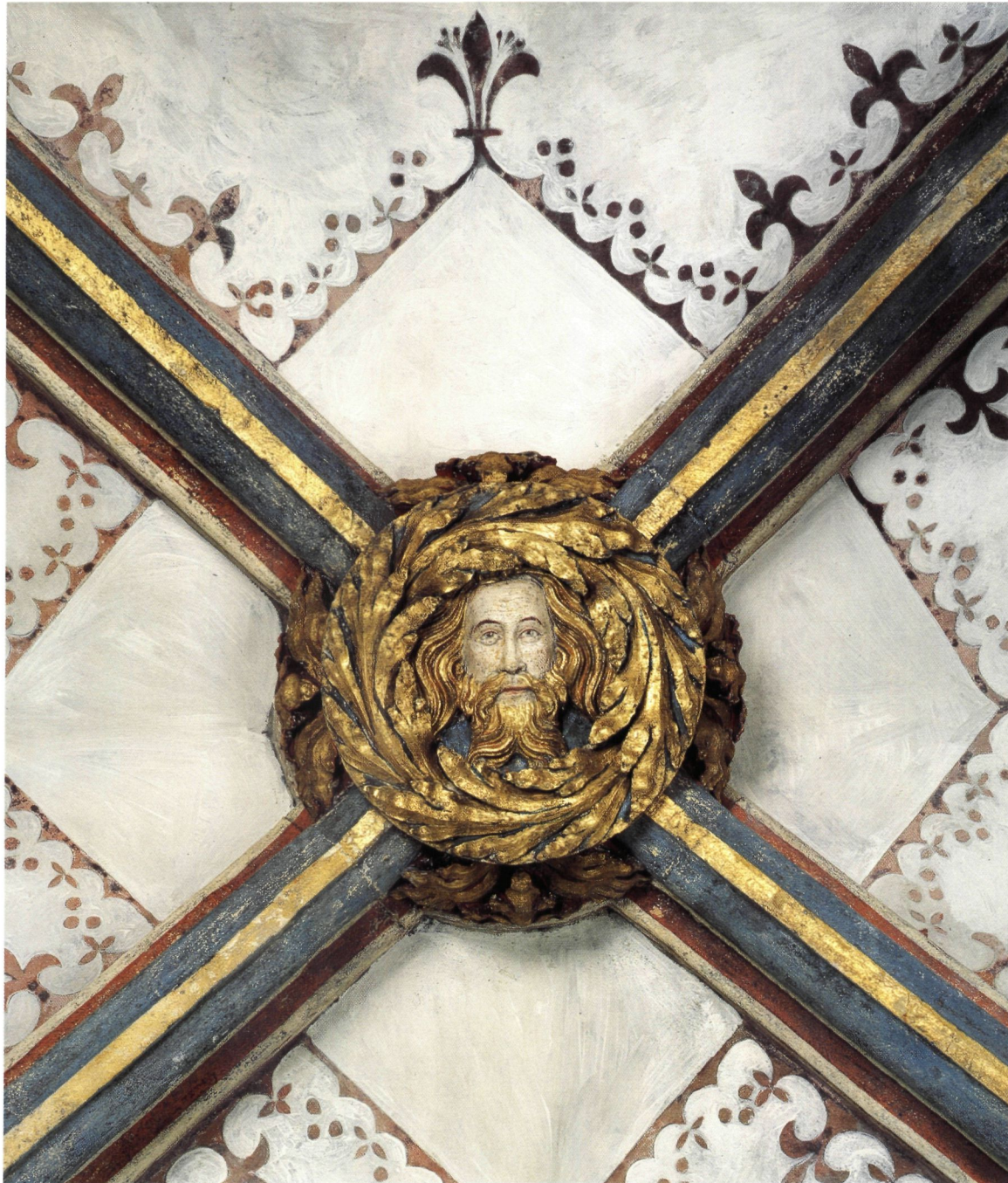
◀ Sluitsteen in de zuidelijke zijbeuk na reiniging en conservering van de sjabloonschildering (foto O. Pauwels)
