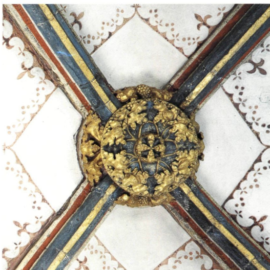
▶ Sluitsteen in de noordelijke zijbeuk (foto O. Pauwels)
