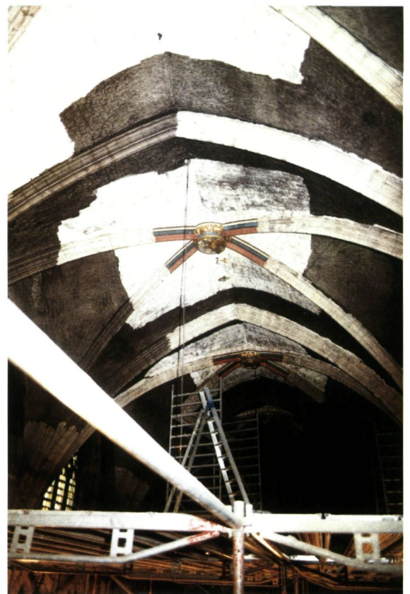
► De gewelven van de middenbeuk tijdens de reiniging (foto K. Breda)
