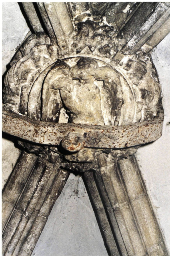
▲ Gedecapeerde en beschadigde sluitsteen in een transkapel (foto K. Breda)
