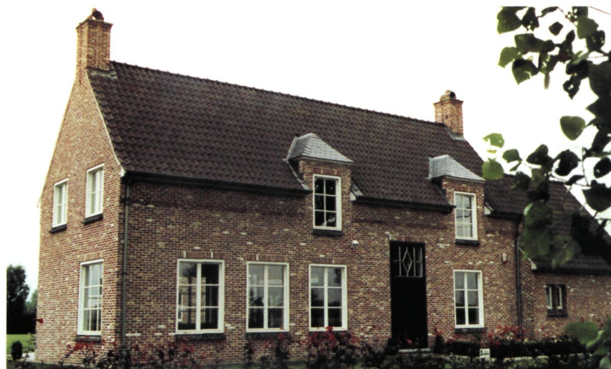
Het „Dupont house“ te Wetteren met blauw gesmoord dak
