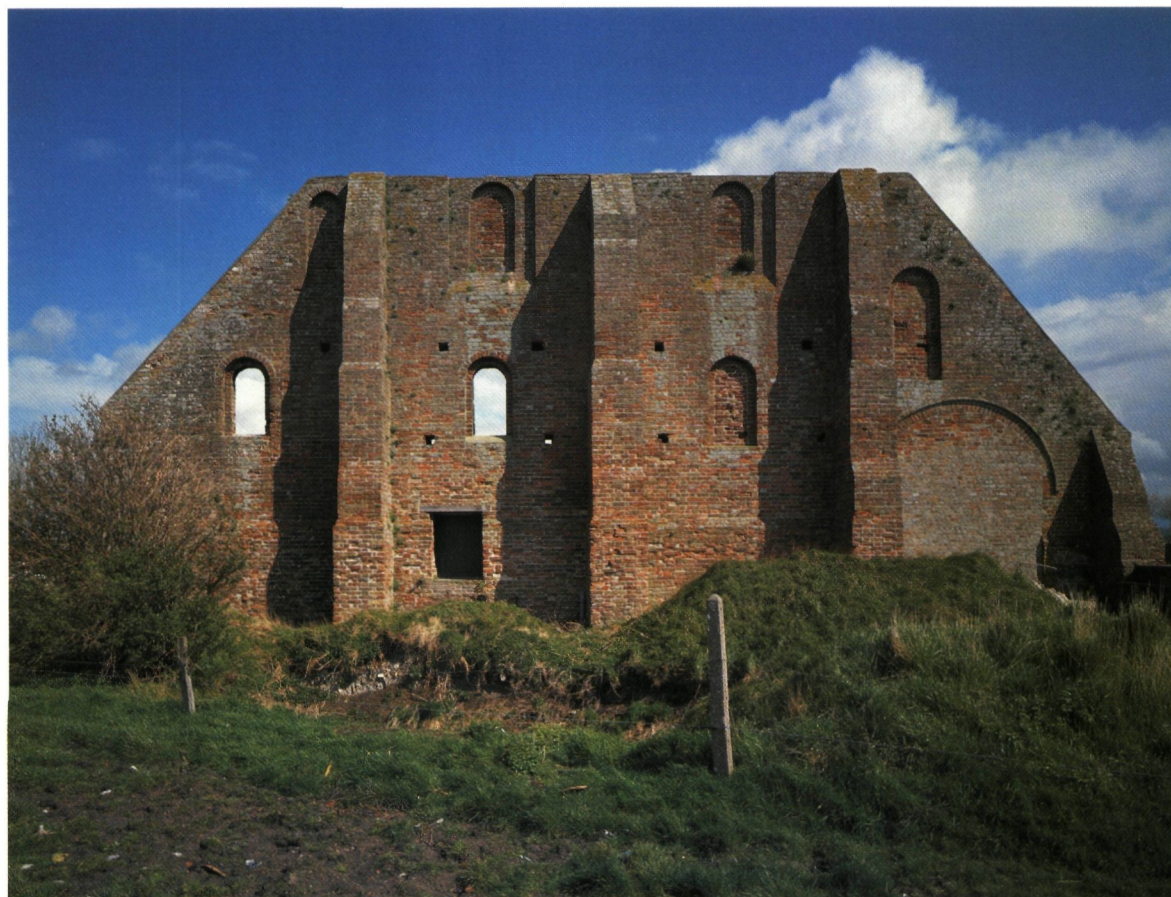
De westgevel van de grote schuur, huidige toestand (foto O. Pauwels)
