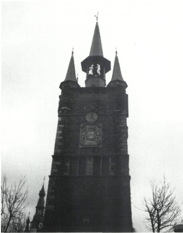
Restauratie Halletoren te Kortrijk.
