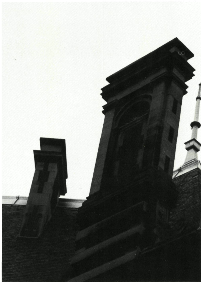
Toestand vóór restauratie
