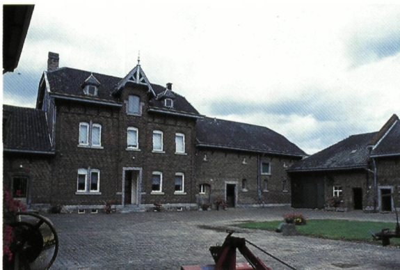
Teuven. Kloosterhofstraat nr.12. De hoeve "Kloosterhof", gebouwd na de brand van het oorspronkelijke gebouw in 1892 (eigen foto)
