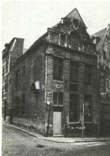
Brussel, Het Huis Schott vóór en na de restauratie (foto G. Batz)
