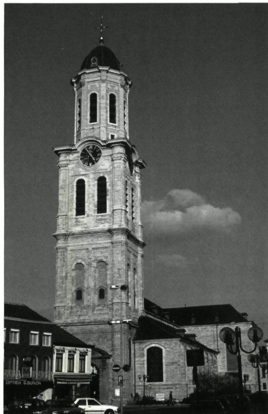
Restauratie Sint-Laurentiuskerk te Lokeren
