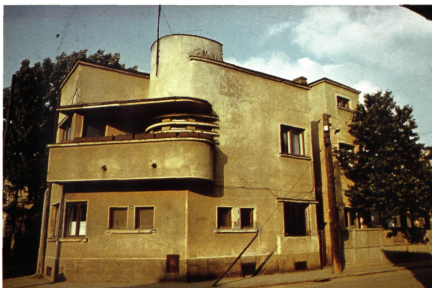
Monumentale bouwvormen voor een piepklein huis, in de aan afbraak ontsnapte Viitor straat uit de jaren '30 (foto S. Manciulescu)
